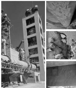
Fig. 1. Torre de precalentamiento con elementos estructurales degradados
