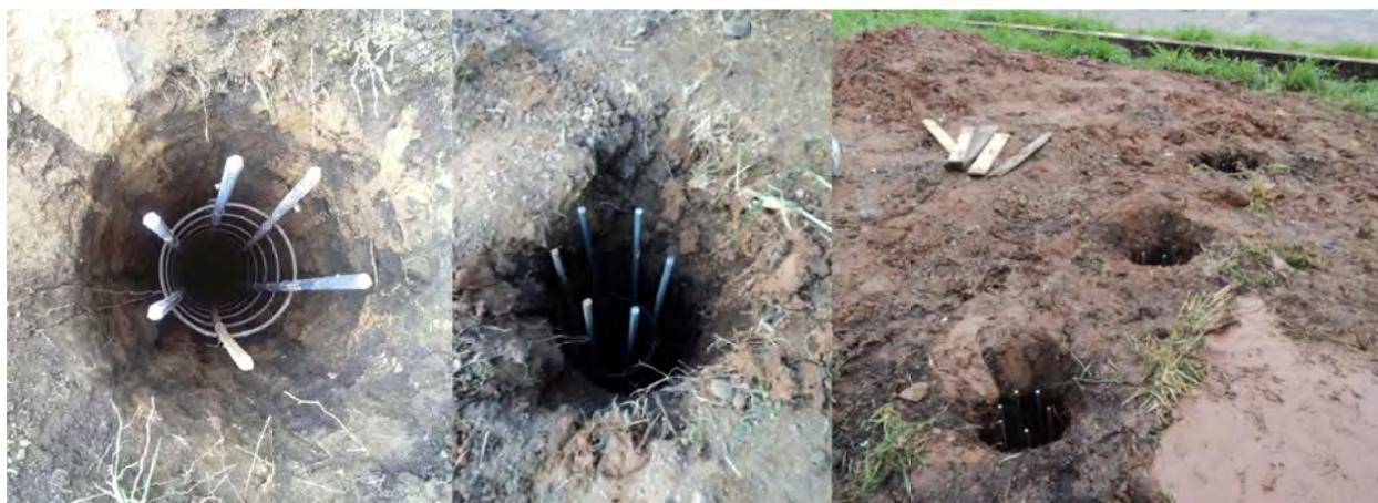
Figura A.11: Excavaciones finalizadas y armaduras ubicadas en posición.
