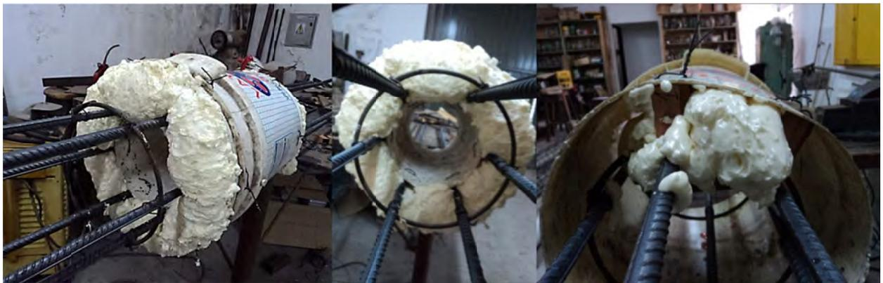
**Figura A.3:** Colocación del poliuretano expandido.
