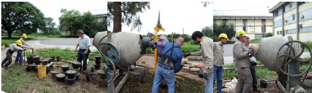
**Figura A.13:** Vertido de los materiales dentro de la hormigonera.
