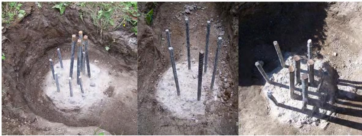
**Figura A.24:** Superficie expuesta de los pilotes y barras longitudinales.
