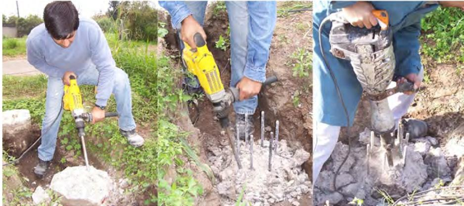
**Figura A.23:** Desmochado de los pilotes.
