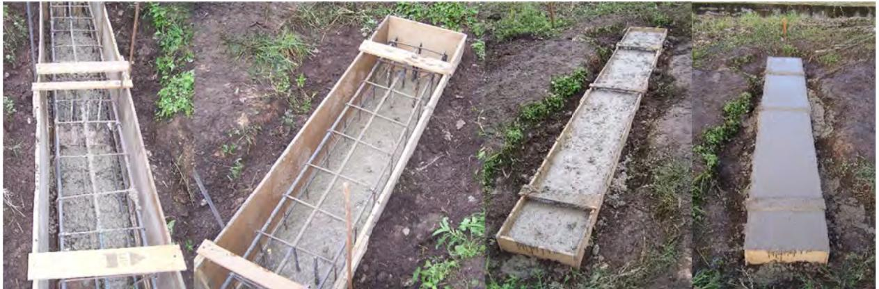
**Figura A.32:** Avance del hormigón dentro del encofrado.
