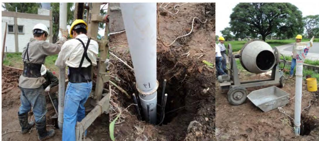
**Figura A.12:** Descenso de la cañería y ubicación del embudo.
