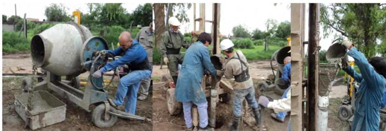
**Figura A.14:** Vertido del hormigón dentro de la cañería.
