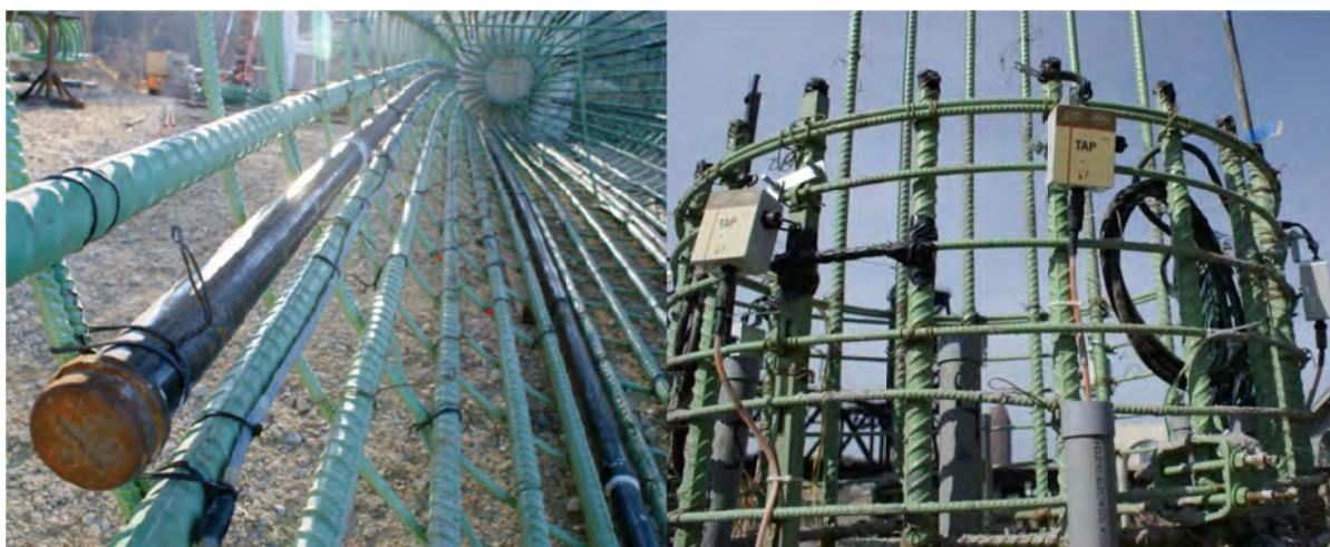
**Figura 2.13:** Cables térmicos anclados a la armadura (izquierda) y unidades de recolección de datos conectadas a los cables (derecha).
