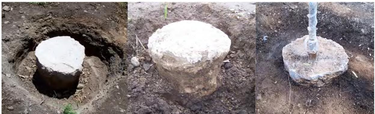
**Figura A.18:** Detalle de los fustes.
