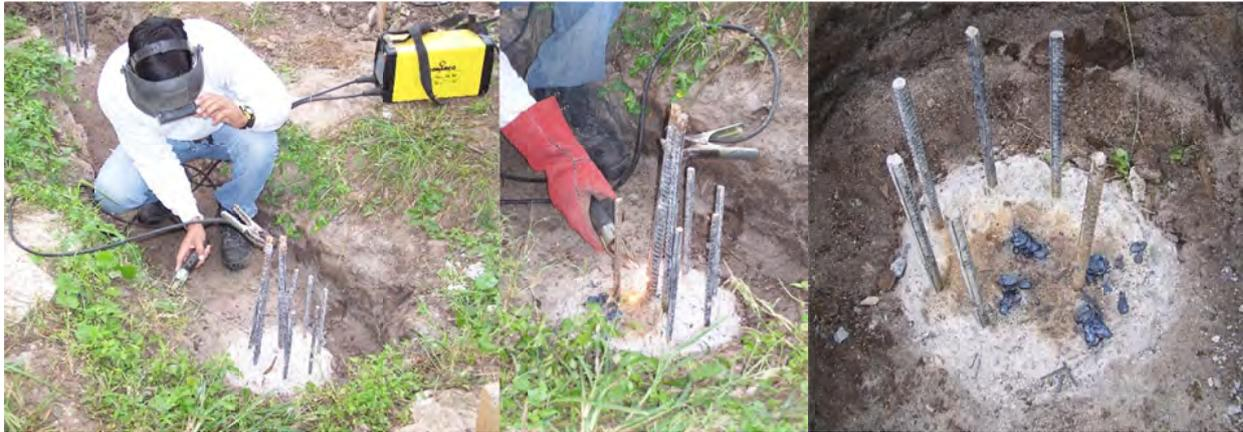
**Figura A.25:** Cortado de las barras de anclaje.
