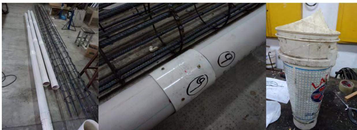
**Figura A.6:** Cañerías y embudo para el hormigonado.
