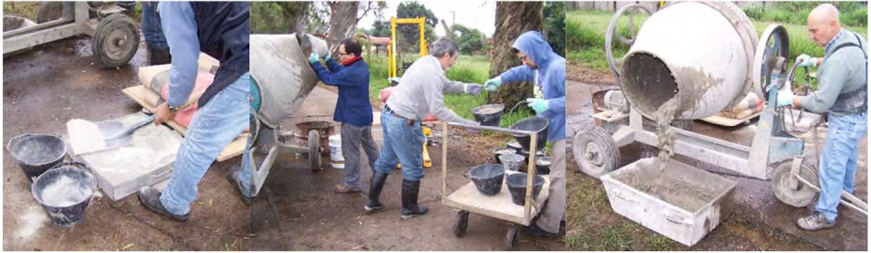
**Figura A.30:** Confeccionado del hormigón.
