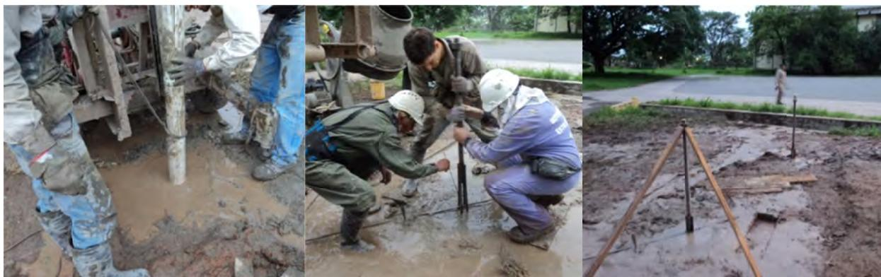
**Figura A.15:** Fin del hormigonado y colocación de las varillas roscadas.
