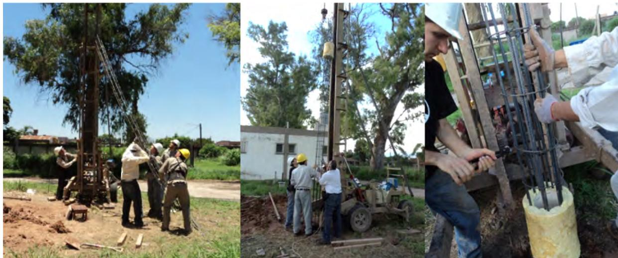
Figura A.10: Descenso y empalme de las armaduras.
