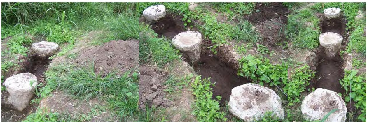
**Figura A.22:** Excavación entre fustes.
