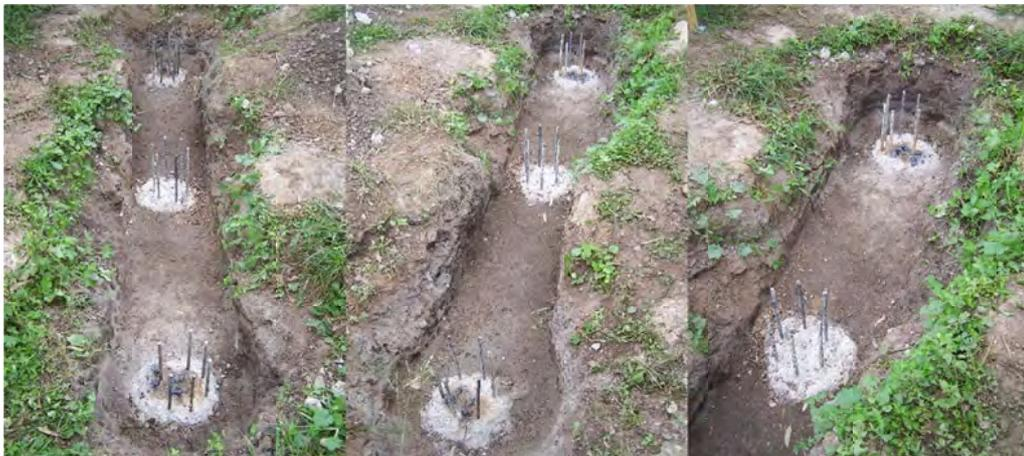
**Figura A.26:** Excavación previa al hormigonado.
