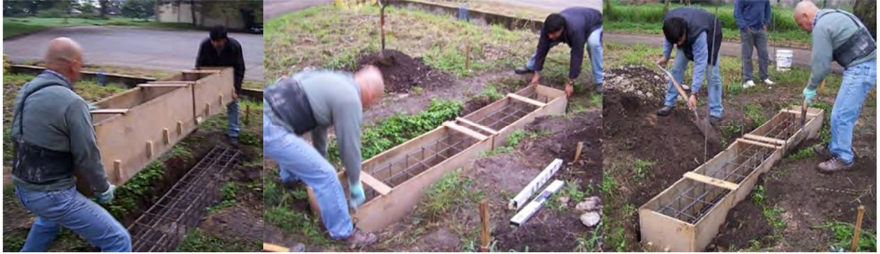
**Figura A.28:** Ubicación del encofrado.
