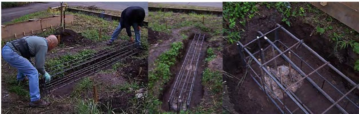
**Figura A.27:** Descenso de la armadura.
