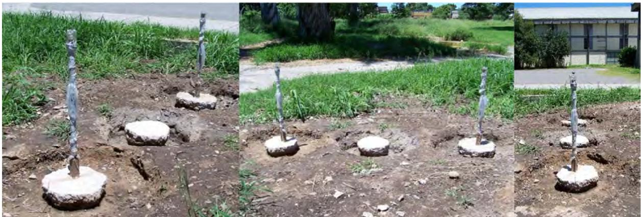
**Figura A.17:** Pilotes hormigonados.
