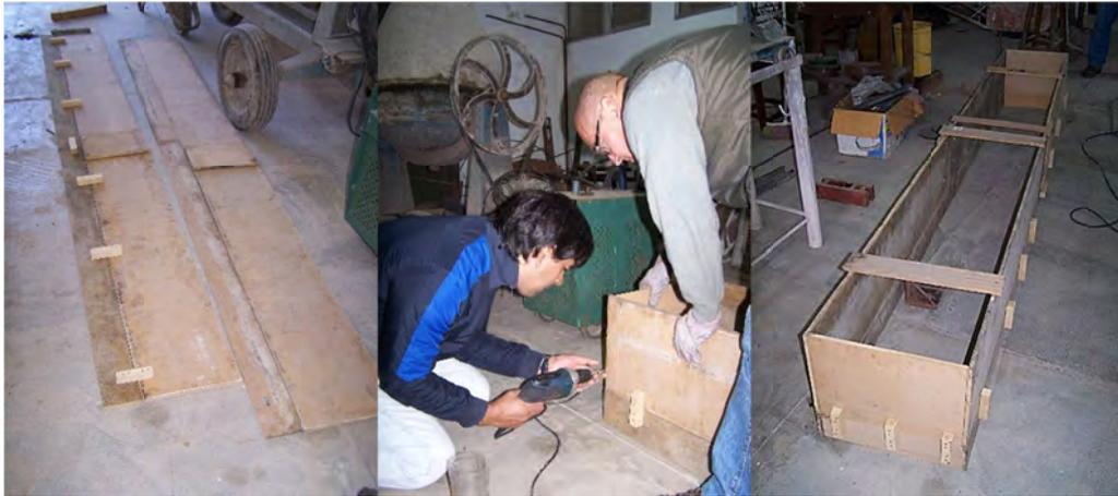
**Figura A.21:** Confección del encofrado.
