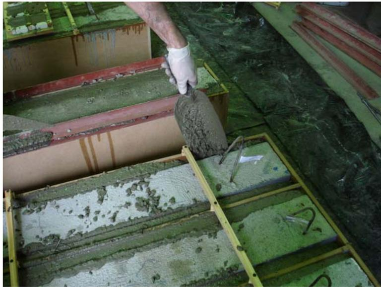
Figura 3.20. Llenado de laterales de encamisado con HRF.
