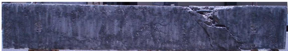
Figura 3.16. Estado previo a la reparación de viga 6 cara derecha.
