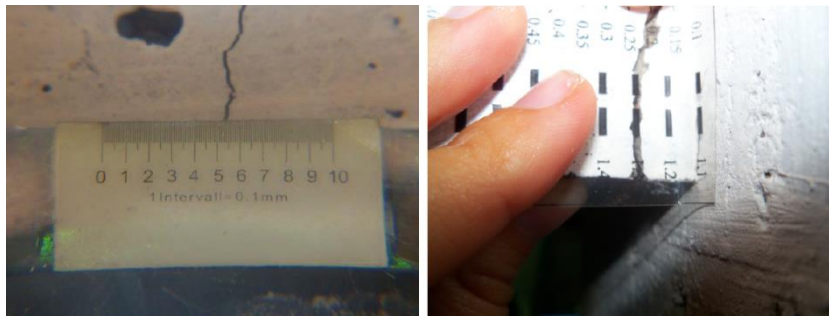
Figura II. 14 - Medición de Ancho de Fisura Residual por Comparación (Scotta [40] , 2013).
