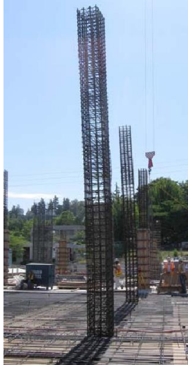
Figura II. 6 – Armadura en Espera de una Columna de Hormigón Armado en Zona con Elevada Peligrosidad Sísmica.
