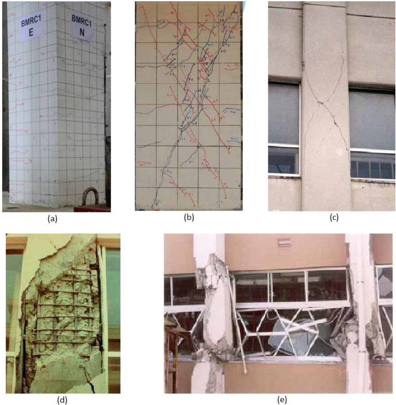
Figura II. 10 – Niveles de Daño en Columnas de Hormigón Armado (a) Nivel de Daño I; (b) Nivel de Daño II; (c) Nivel de Daño III; (d) Nivel de Daño IV; (e) Nivel de Daño V. (Arista Poegoeh [5] , 2013).
