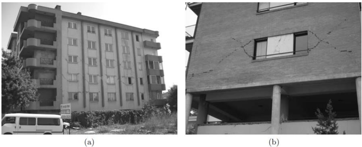
Figura II. 3 - Fotos de Edificios de Hormigón Armado con Daño Moderado: (a) Sismo de Izmit, Turquía M_w = 7,4 , 1999; (b) Sismo de L'Aquila, Italia M_w = 6,3 , 1999.
