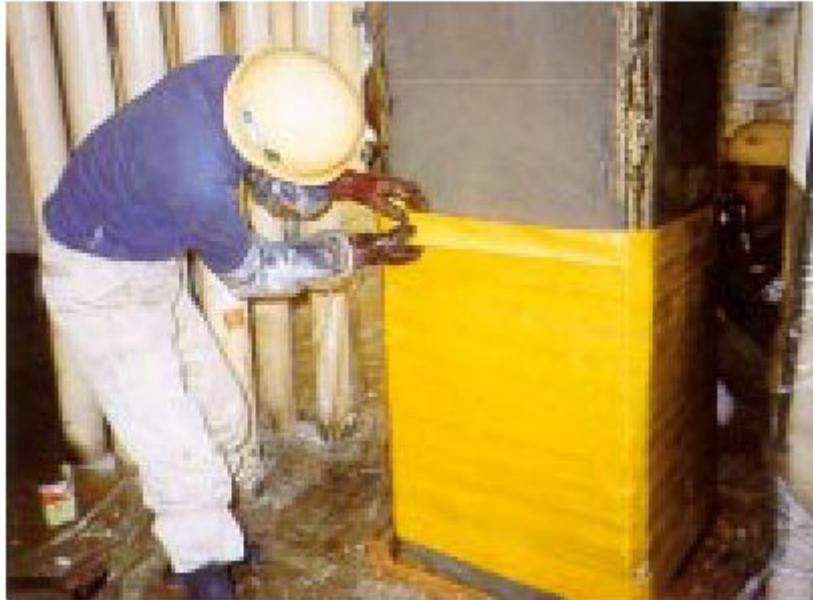
Figura 2.15. Pilar de puente reforzado con AFRP (International Technology Research Institute, EEUU, 1998).
