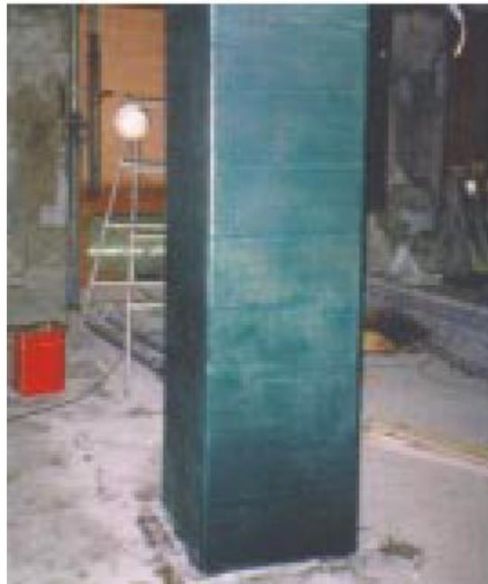
Figura 2.14. Columna de edificio reparada con CFRP (International Technology Research Institute, EEUU,1998).
