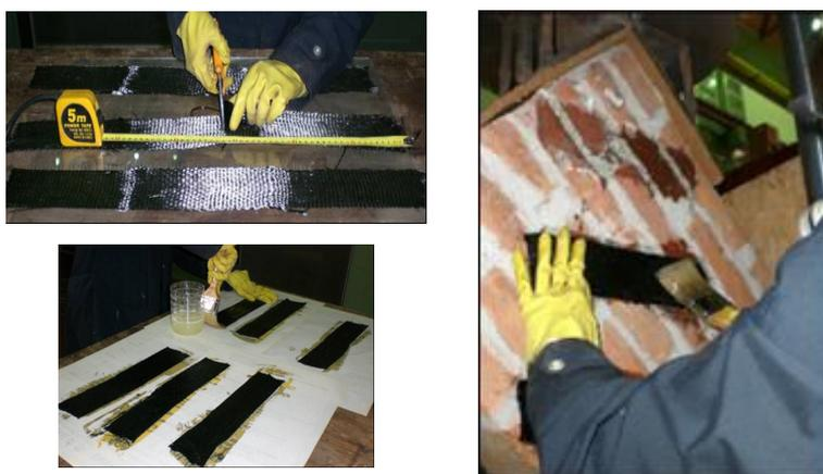
Figura 4.3. Técnica de refuerzo y/o reparación de mampostería con polímeros reforzados con fibras de carbono.
