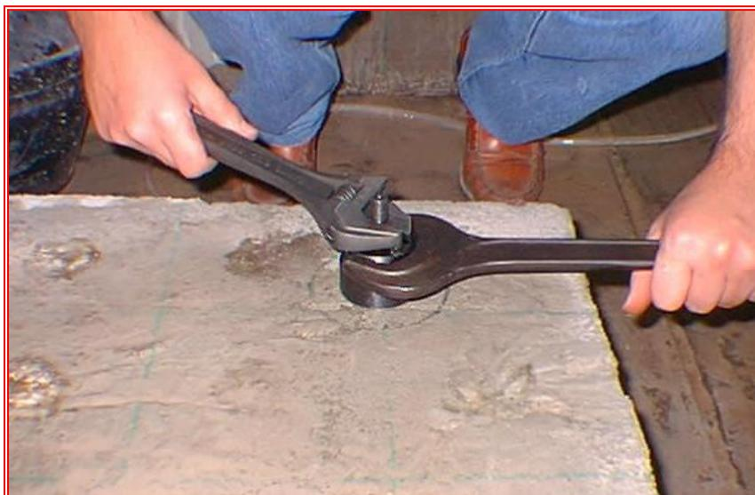
**Fotografía N° 8: Expansión de la arandela mediante el ajuste de la tuerca**
