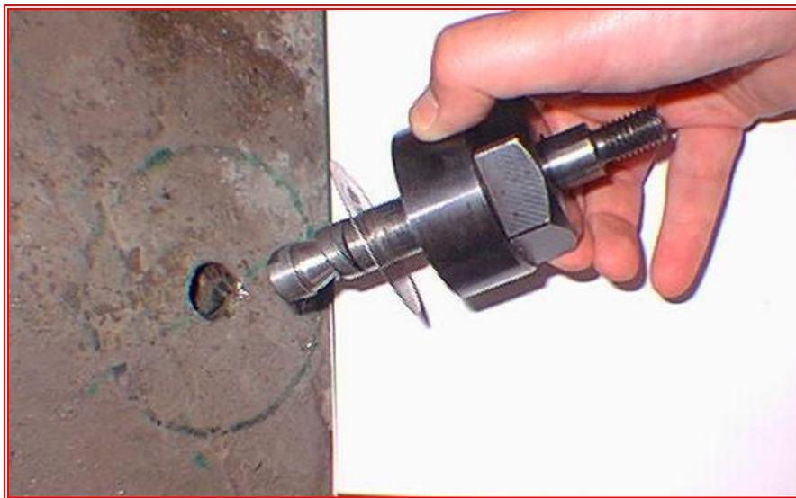
**Fotografía N° 7: Colocación del inserto con la arandela expansible**
