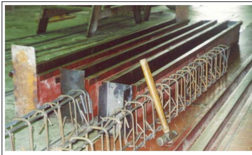
*Figura 6.9. Encofrados*
