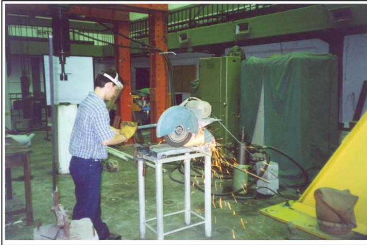
*Figura 6.10. Cortado de hierros para armadura*
