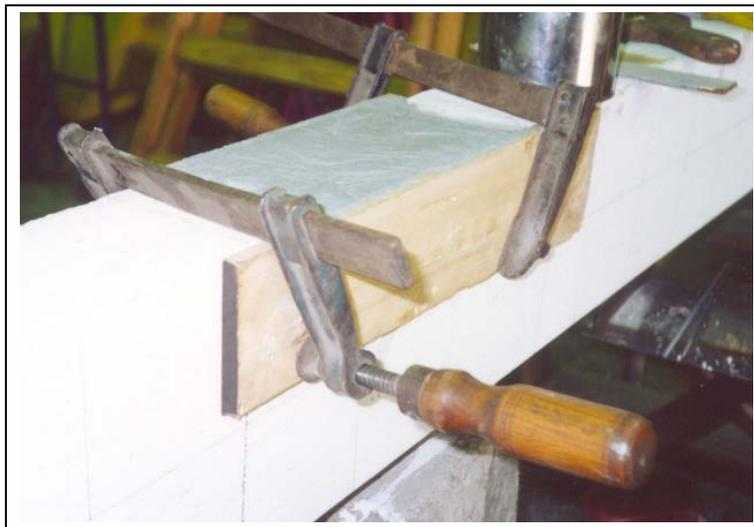
*Figura 6.17. Estado final de la reparación con Sikadur 41*
