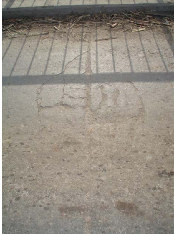
Fotografía 3.21: Junta saltada, grietas y falta de material sellante.
