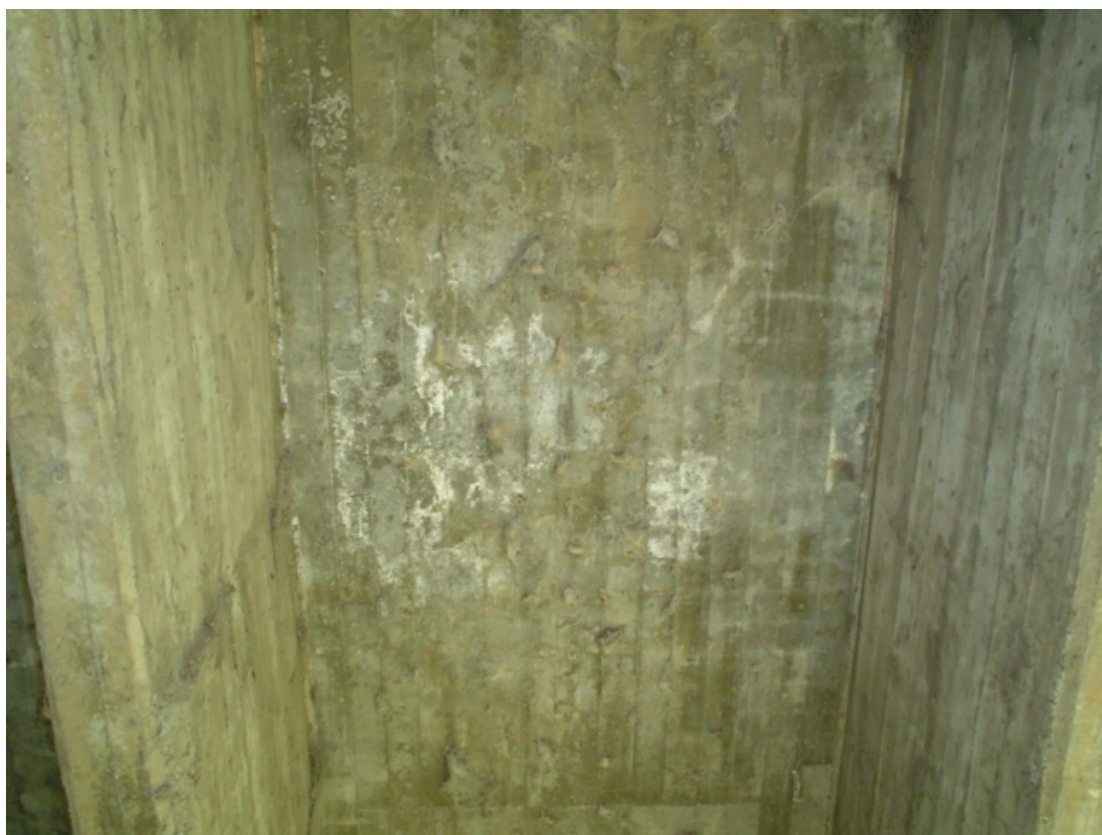
Fotografía 3.9: Manchas de humedad en fondo de losa de tablero
