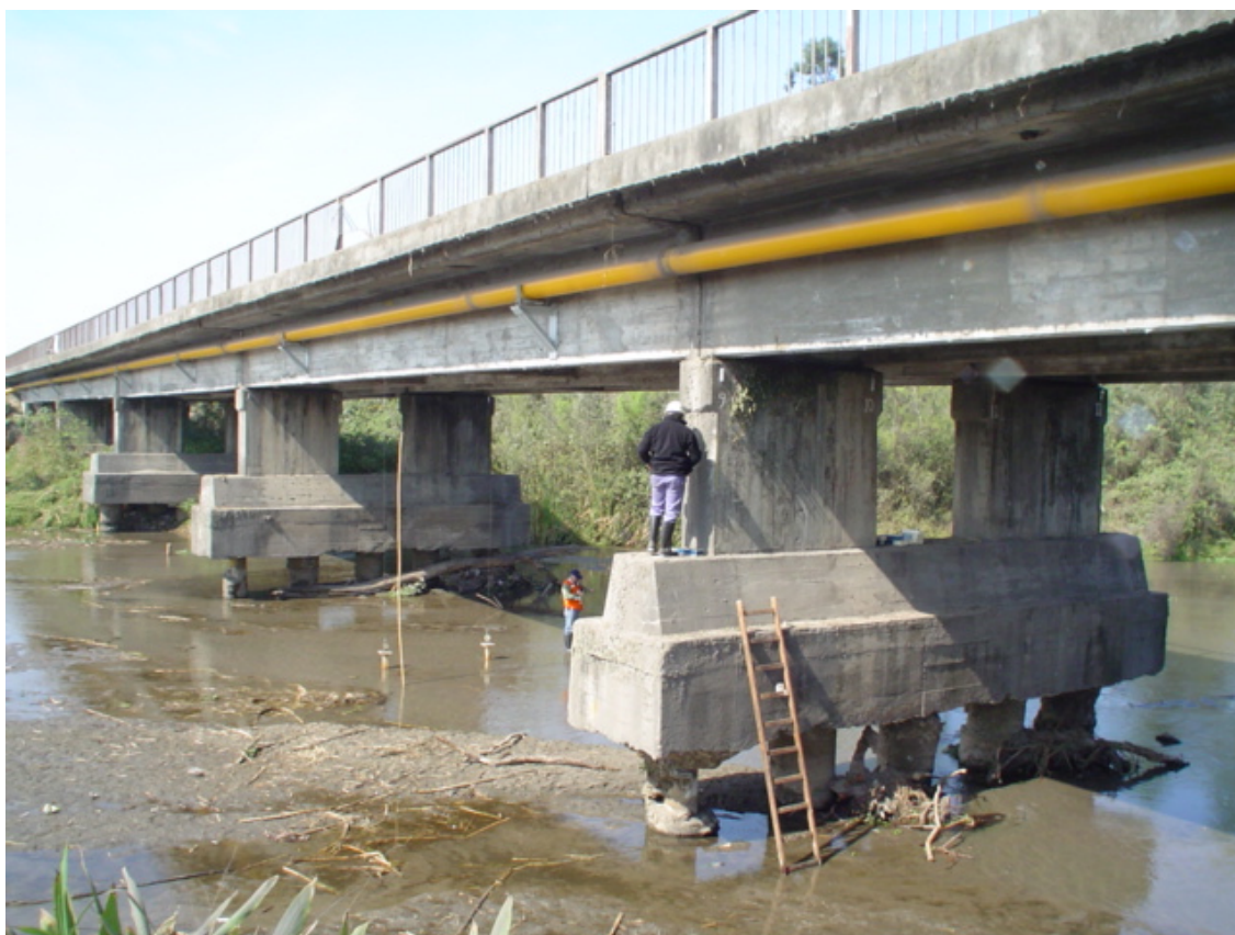
Fotografía 3.5: Erosión generalizada del lecho, socavación en pilas.
