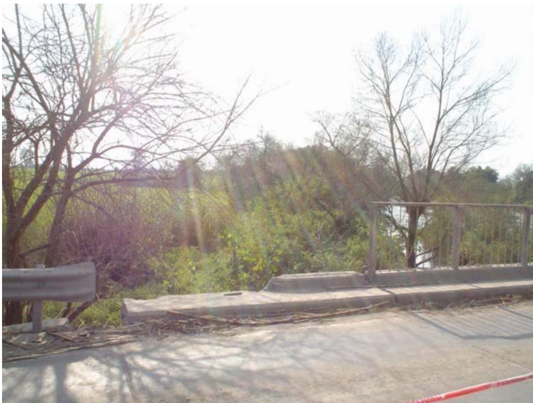
Fotografía 3.25: Faltante tramo de baranda en acceso
