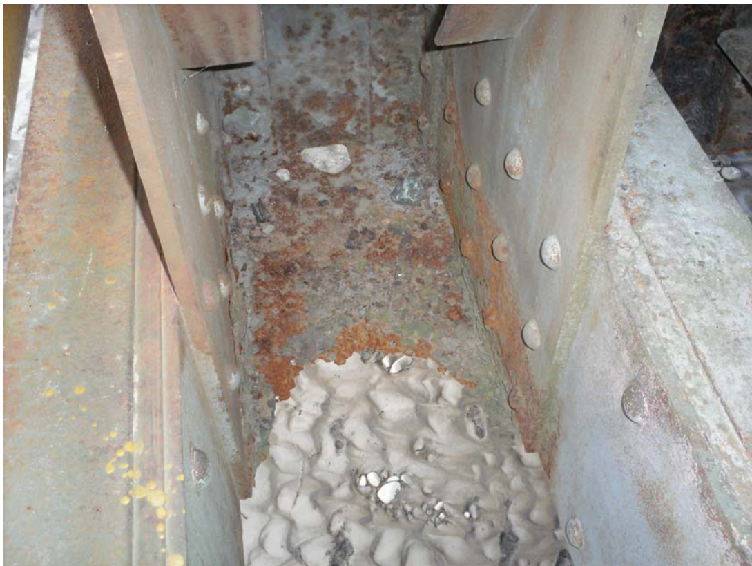
Fotografía 3.41: Corrosión en pañuelo de nudo inferior, en zona exterior
