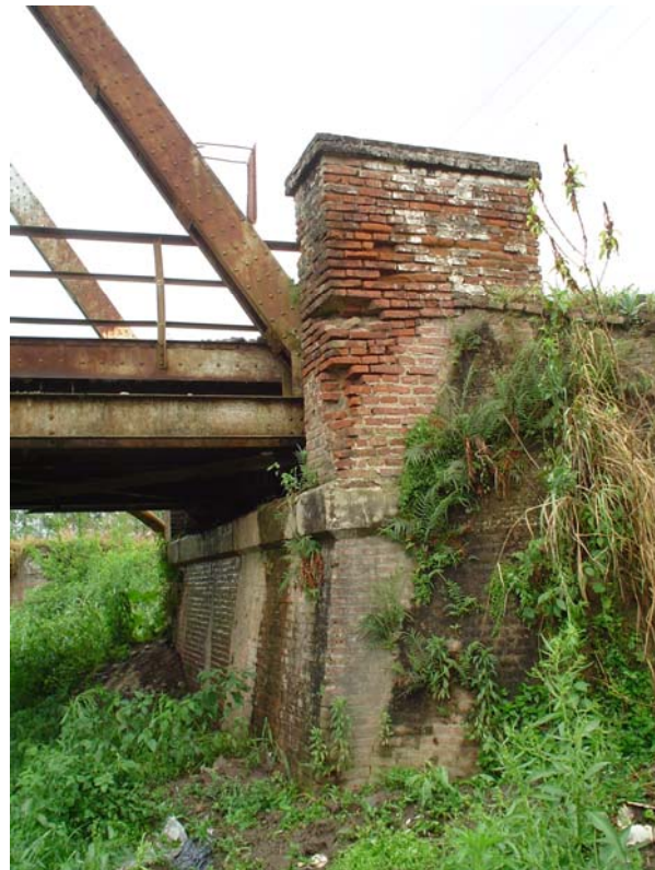
Fotografía 3.38: Estribos del tipo de caras facetadas.
