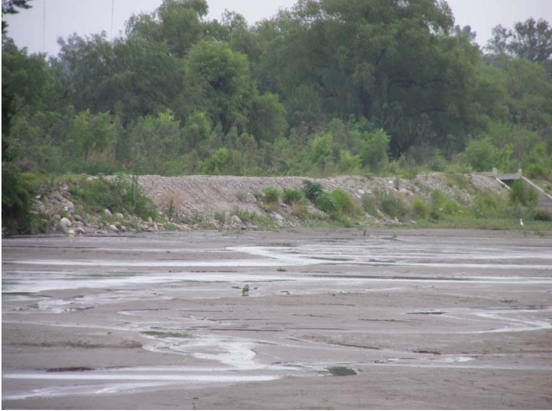
Fotografía 3.34: Defensa aguas arriba sobre margen sur constituida por terraplén de material granular
