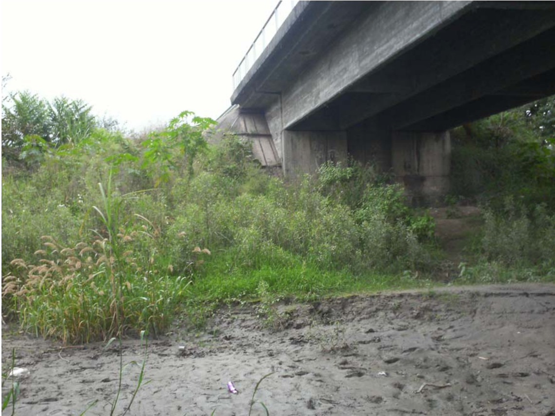
Fotografía 3.6: Extremos redondeados troncocónicos de los estribos, solo aguas arriba.
