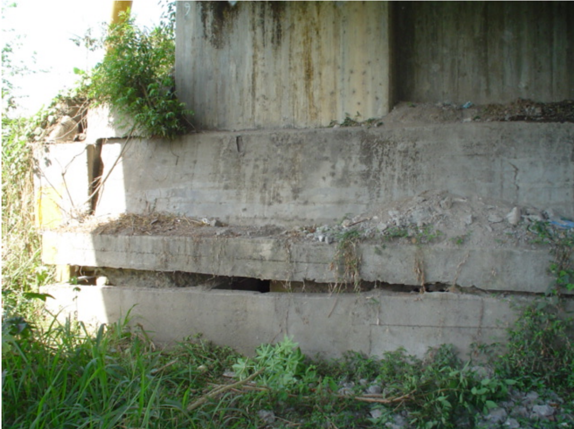
Fotografía 3.18: Desmembrado de la pantalla de protección de pilotes en estribo de margen derecha.
