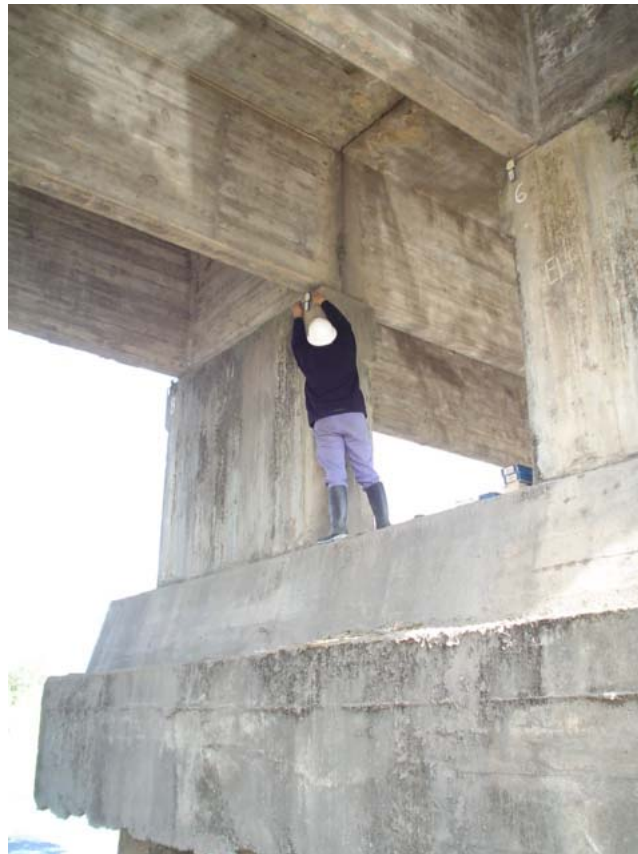
Fotografía 5.1: Puesta a punto de flexímetros de dial en apoyos
