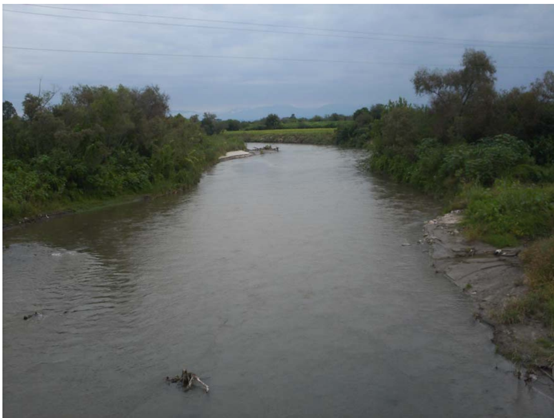
Fotografía 3.4: Márgenes erosionadas del río Pueblo Viejo aguas abajo del puente
