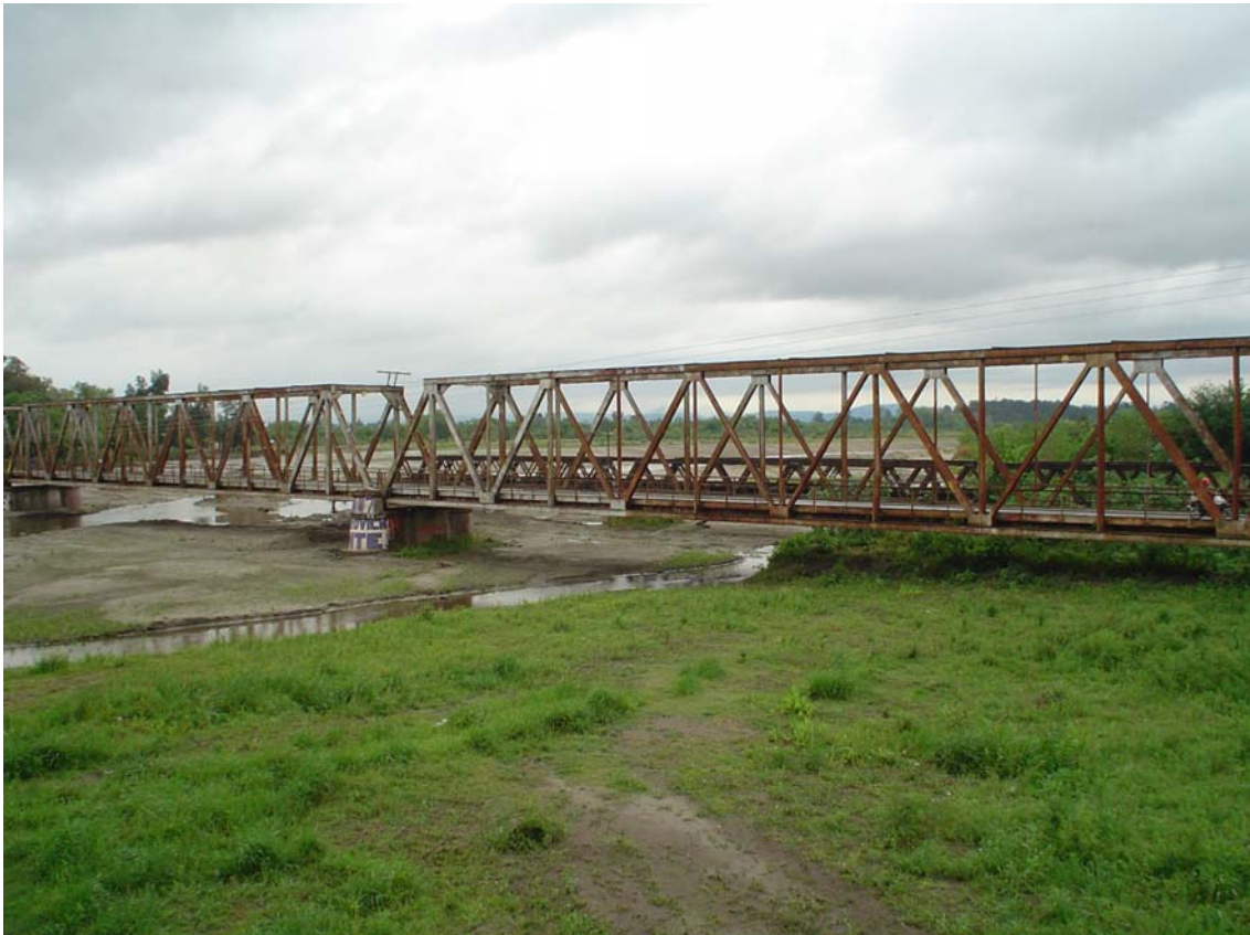
Fotografía 3.32: Vista del puente
