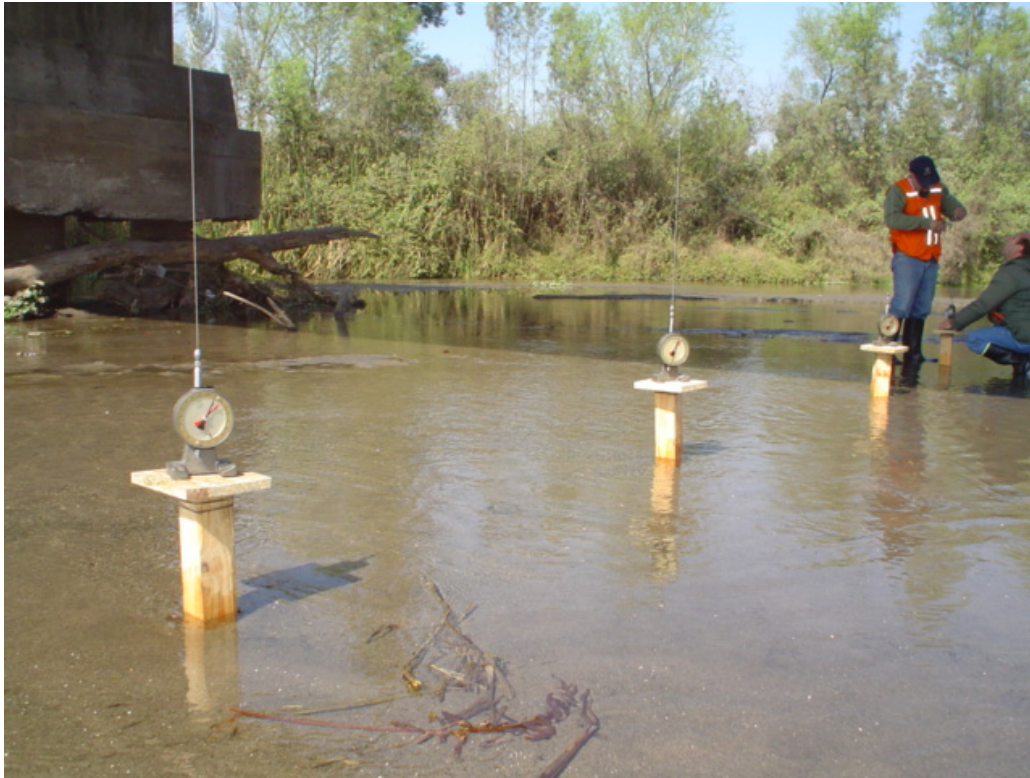
Fotografía 5.2: Puesta a punto de flexímetros de cable en centro de tramo
