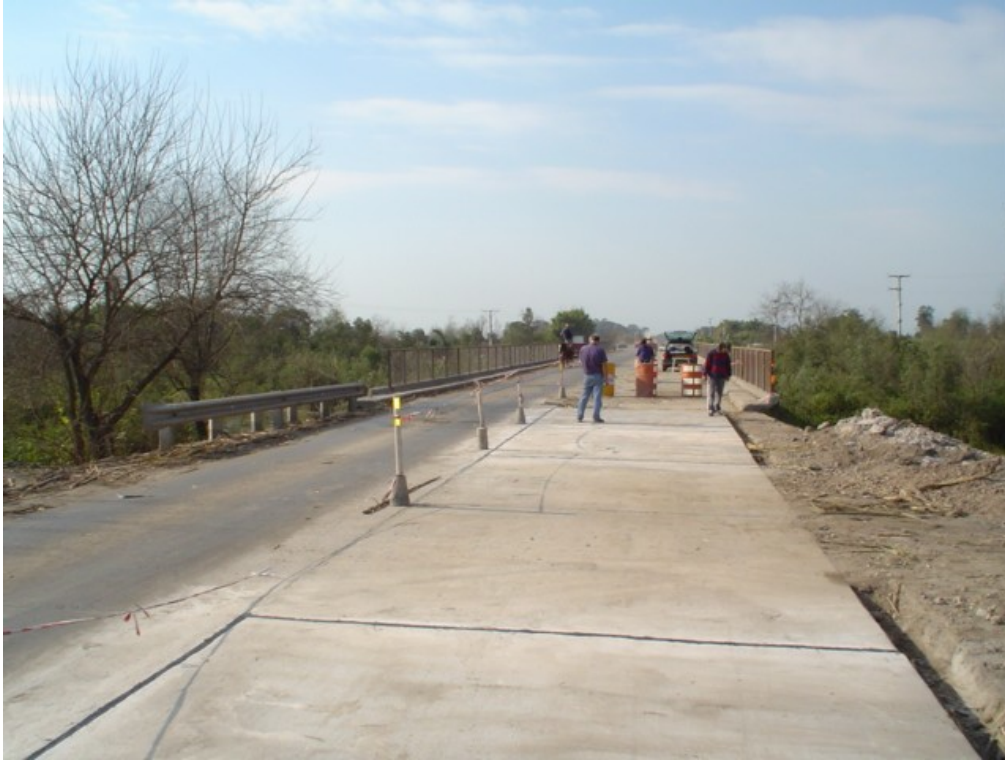
Fotografía 3.2: Reemplazo de pavimento en tramo de aproximación.
