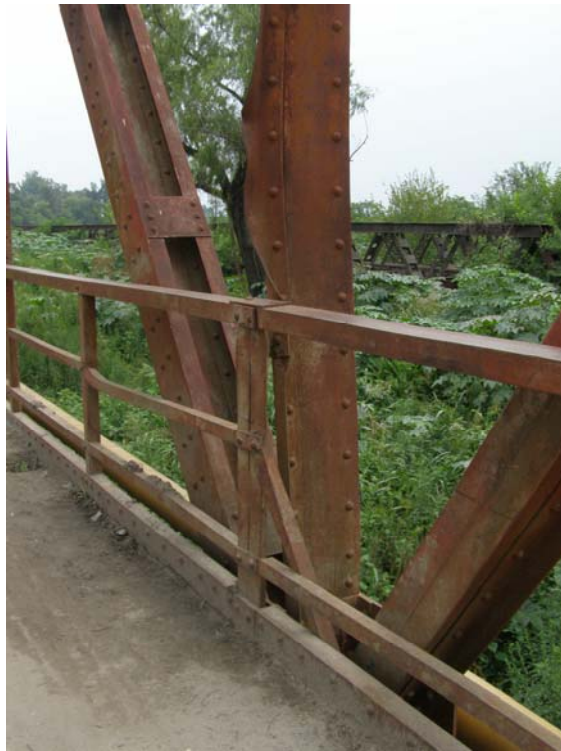
Fotografía 3.40: Montante dañado por impacto.
