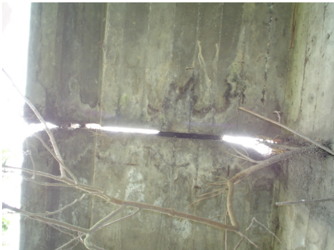
Fotografía 3.10: Deterioro en fondo de losa tablero, en zona de voladizos, provocado por el agua infiltrada.
