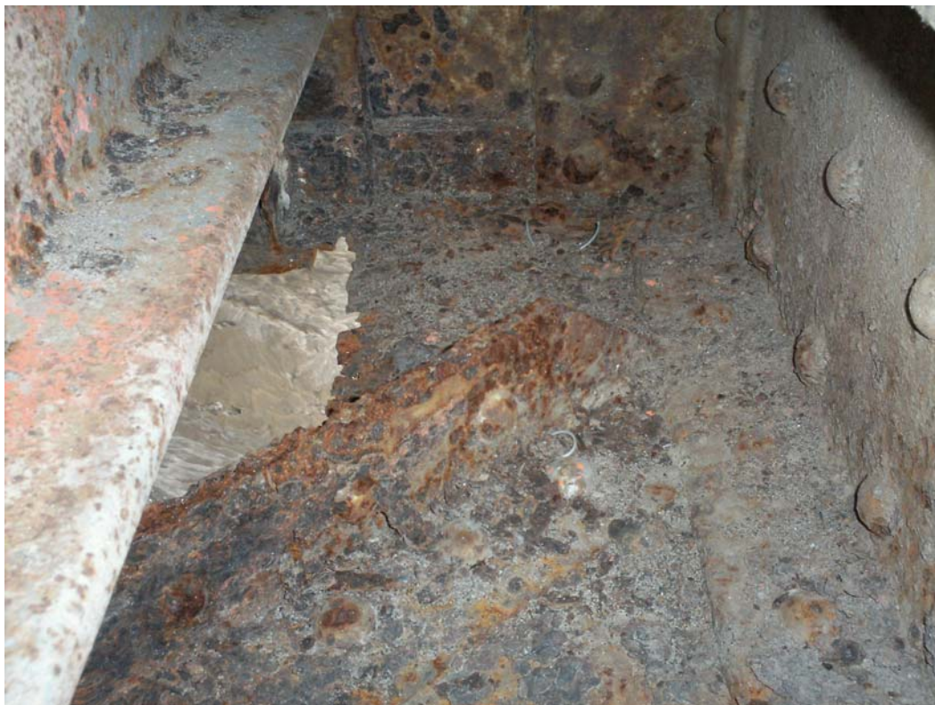
Fotografía 3.42: Nudo inferior, zona interior con pérdida de sección por corrosión
