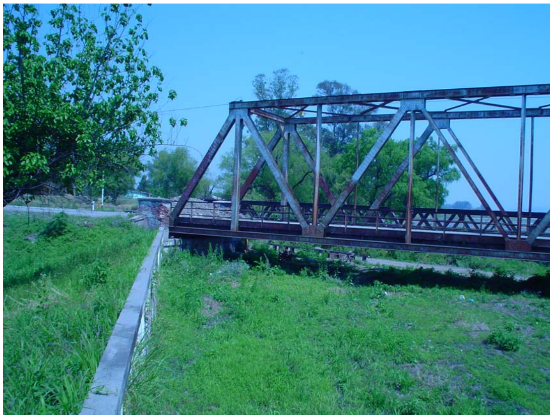
Fotografía 3.35: Tablestacado de la defensa de aguas abajo en margen sur
