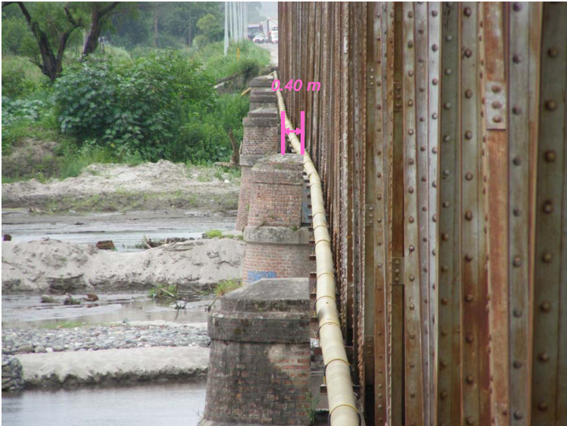
Fotografía 3.46: Rotación de la Pila 2, vista aguas arriba
