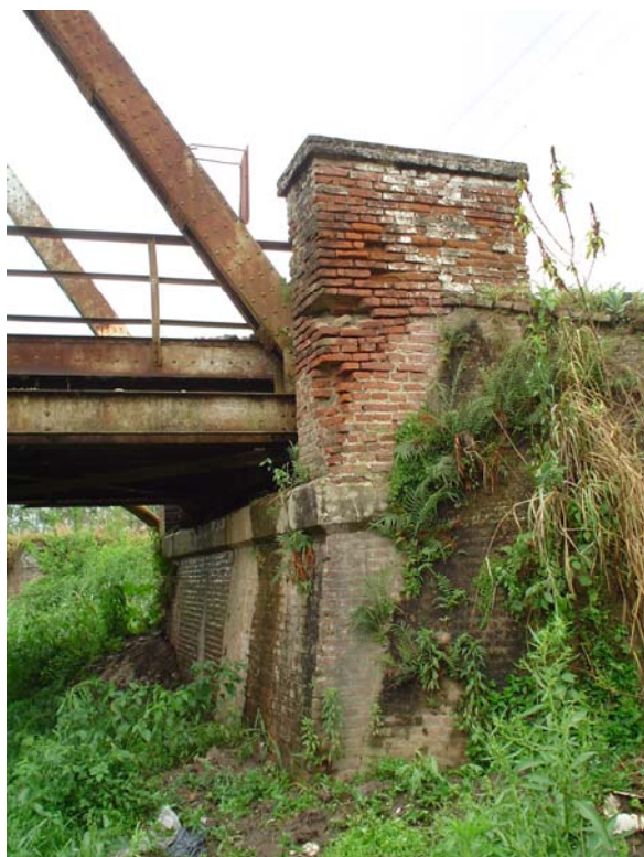
Fotografía 3.45: Estribo Norte, vista este.
