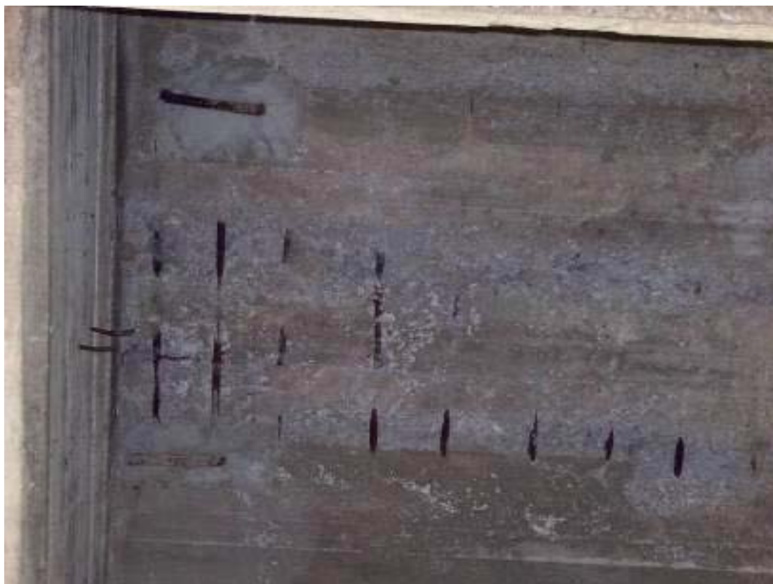
Fotografía 3.8: Armaduras expuestas en fondo de losa tablero
