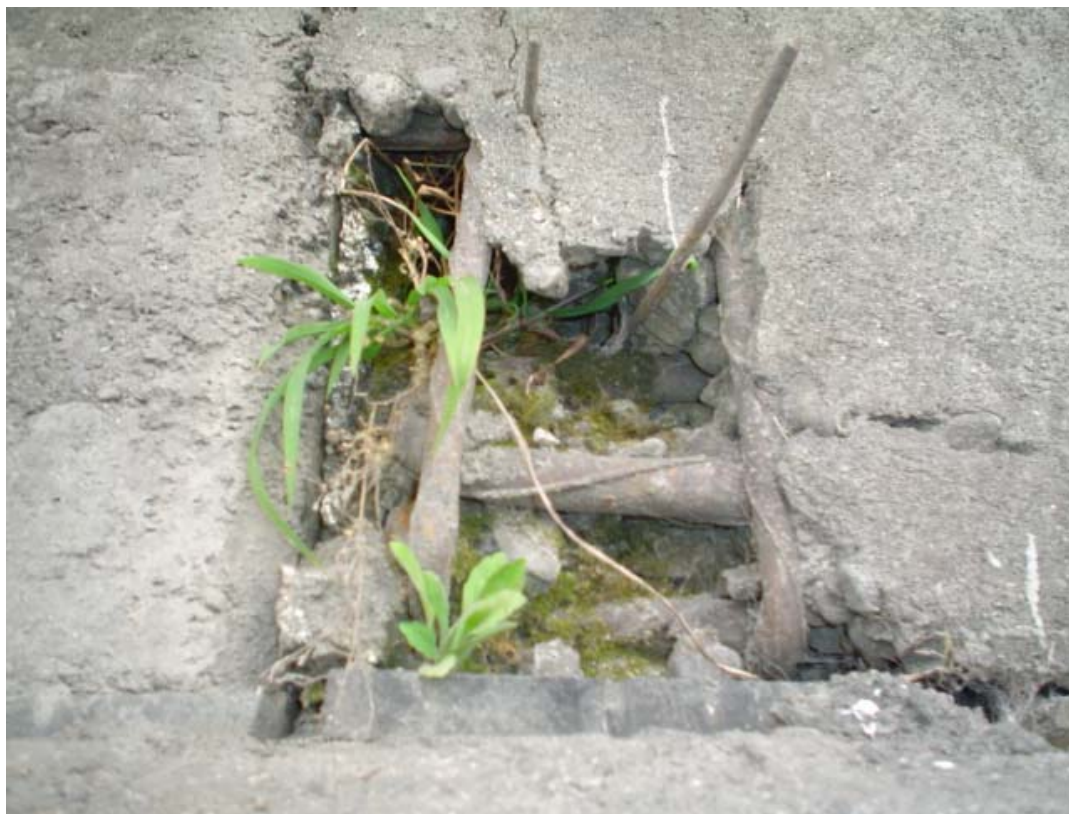
Fotografía 3.12: Defecto de llenado de Viga norte del tercer tramo sobre Pila N° 3
