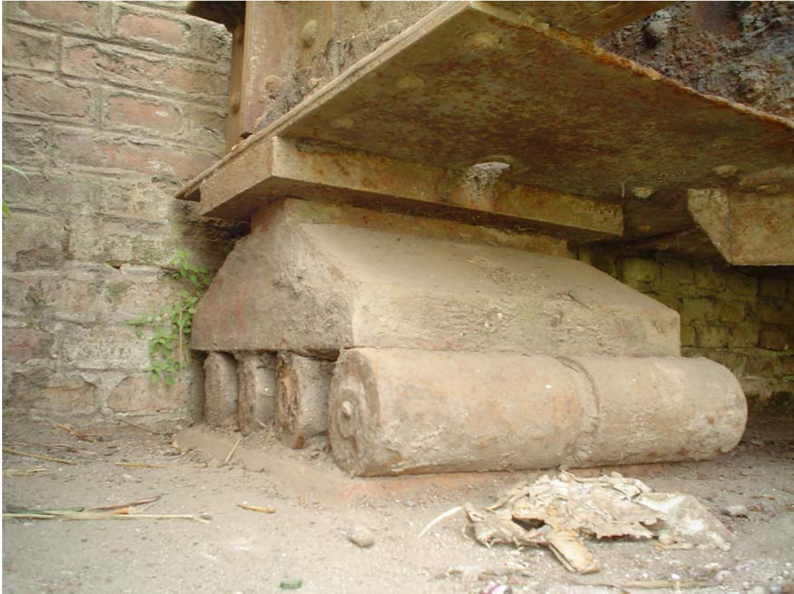
Fotografía 3.53: Apoyo desbancado ubicado sobre el estribo sur
