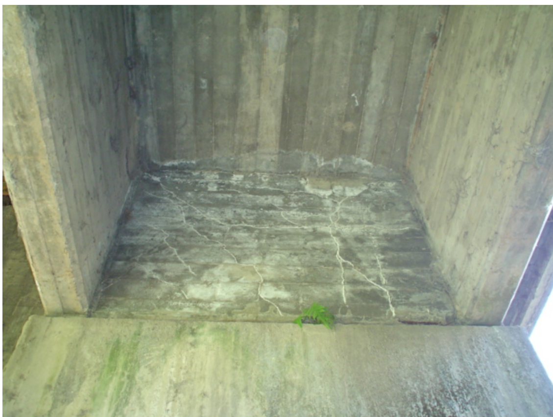
Fotografía 3.16: Manchas de humedad y fisuración en diafragma sobre estribo.
