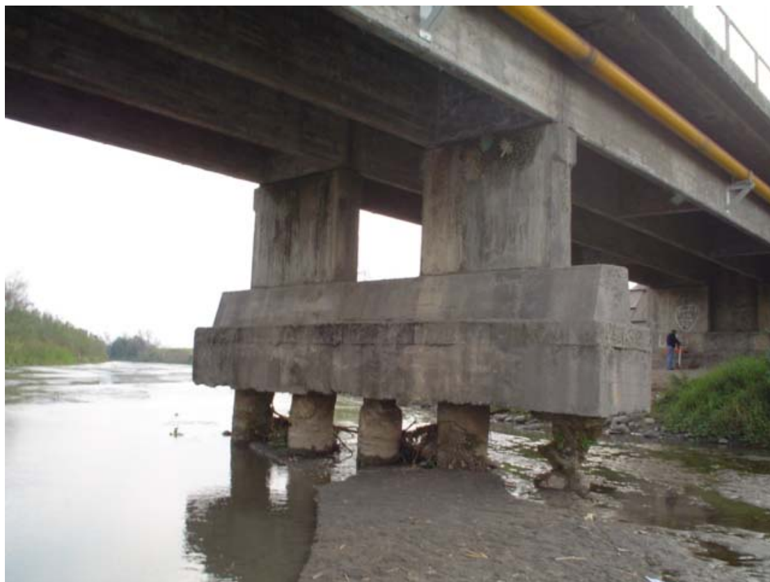
Fotografía 3.19: Erosión de capa de protección de hormigón en extremo superior de pilotes, Pila N° 1
