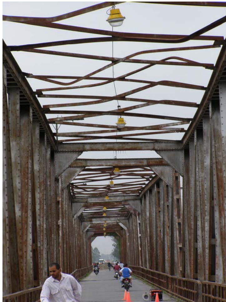
Fotografía 3.39: Deformación de cordones superiores y pandeo en arriostramientos de los tramos 2 y 3
