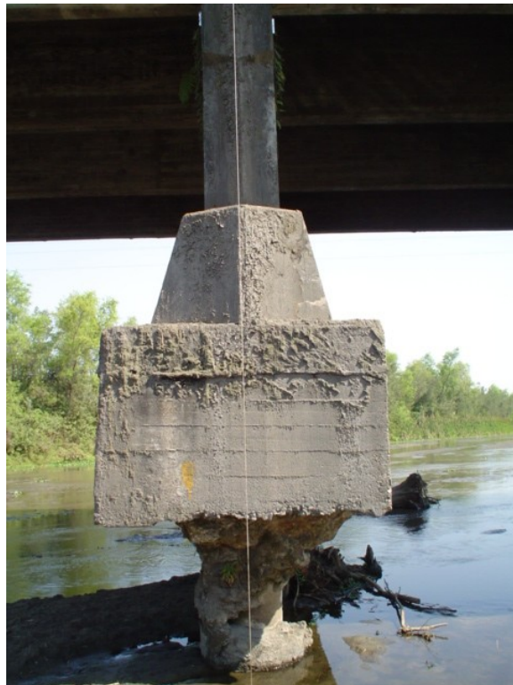
Fotografía 3.17: Verificación de la verticalidad de pilas
