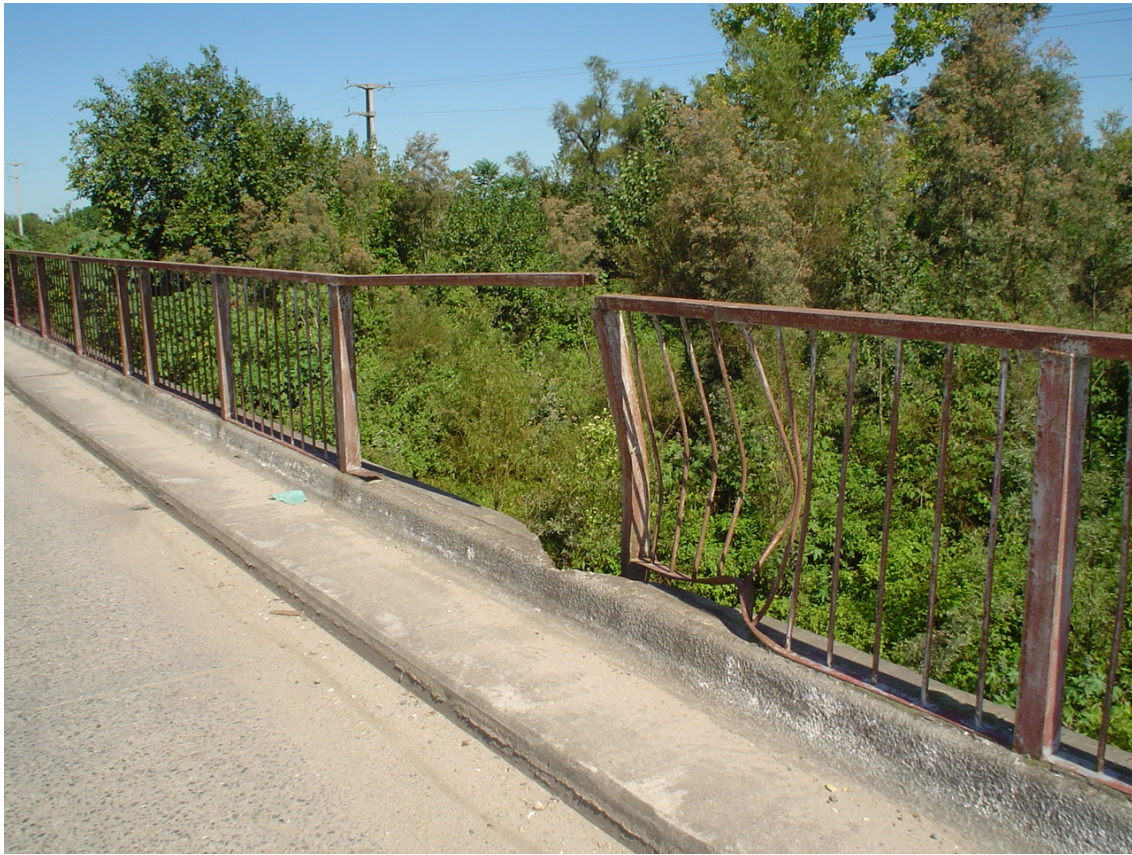
Fotografía 3.29: Daños localizados por impacto de vehículos en la viga de borde de veredas.
