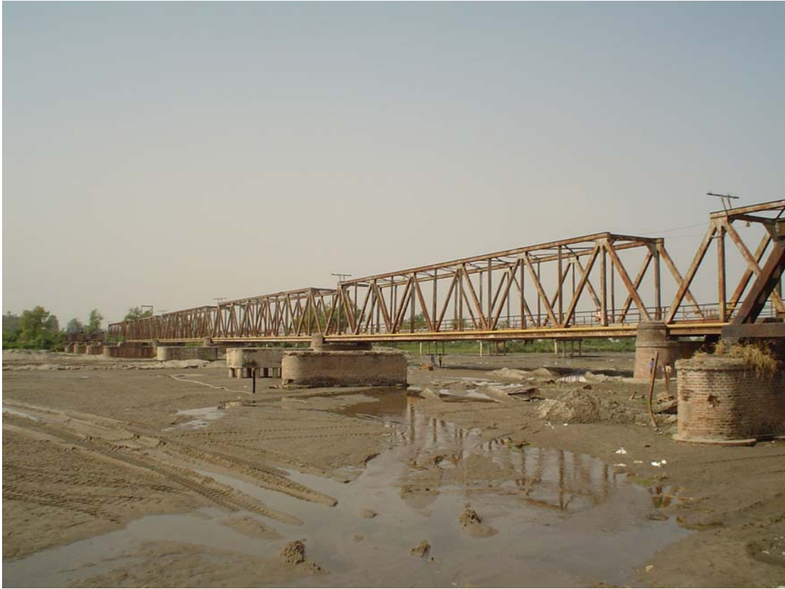
Fotografía 3.37: Cercanía de las Pilas del puente ferroviario
