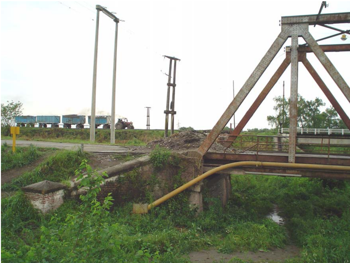
Fotografía 3.44: Estribo Norte, vista oeste.
