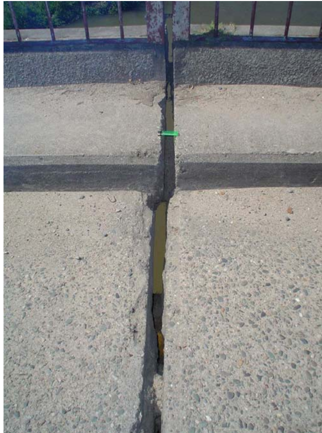
Fotografía 3.23: Descantillado de bordes de juntas
