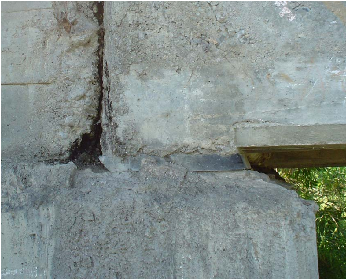
Fotografía 3.28: Desplazamiento horizontal excesivo del elastómero
