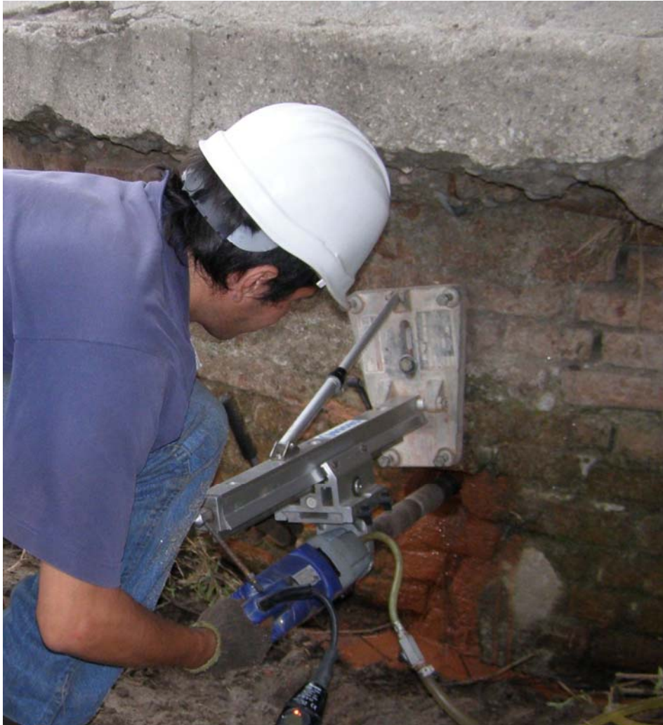
Fotografía 3.48: Extracción de testigo en cilindro de fundación.
