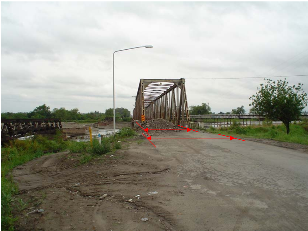
Fotografía 3.33: Anchos de calzada en tramo de aproximación y en el puente mismo.
