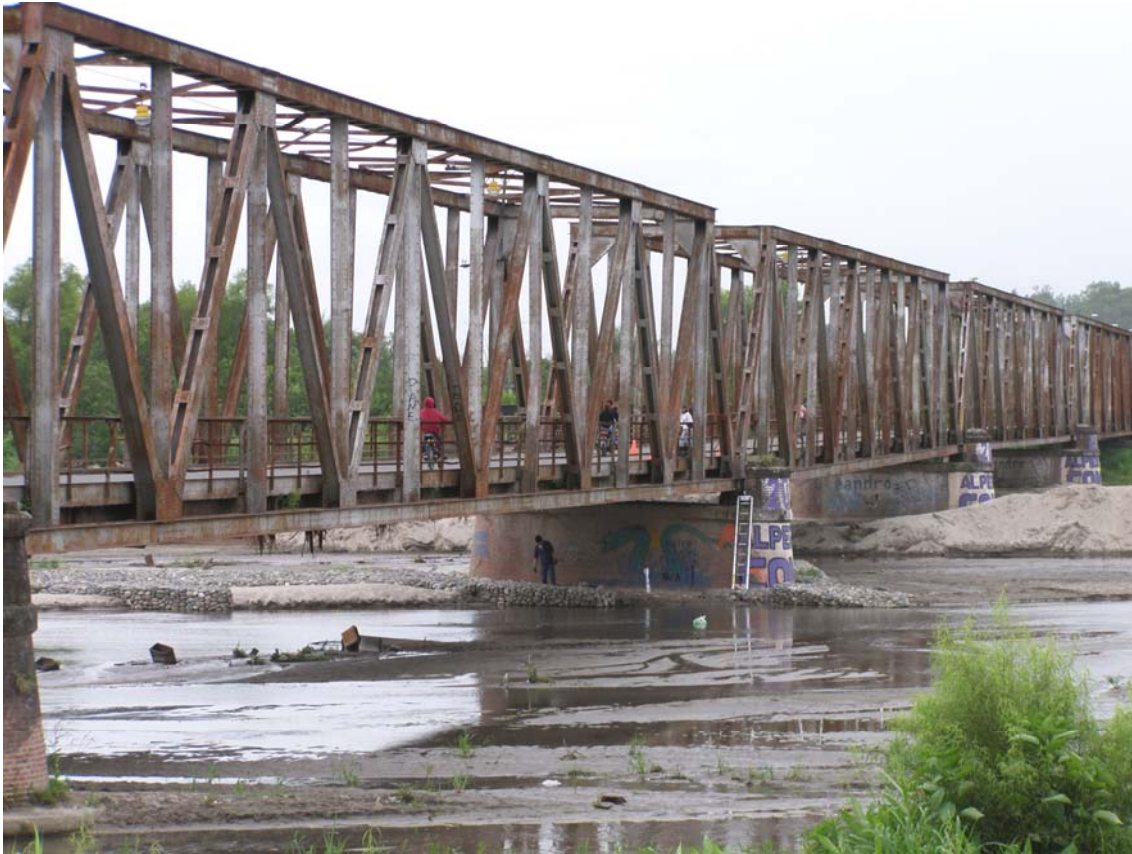
Fotografía 3.47: Rotación de la pila 2, vista aguas abajo
