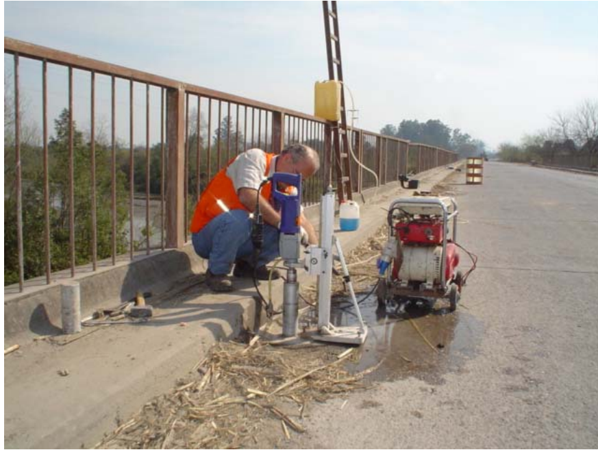
Fotografía 3.30: Extracción de testigos de losa del tablero
