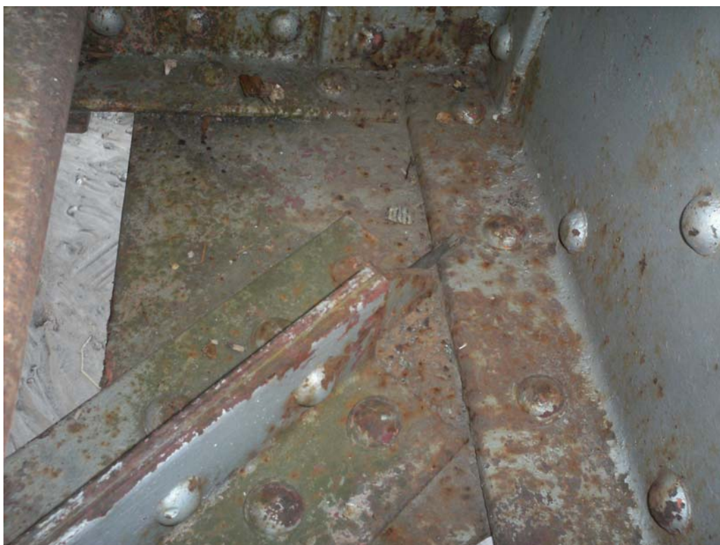
Fotografía 3.43: Nudo inferior, zona interior con principios de corrosión por desprendimiento de la capa de protección.
