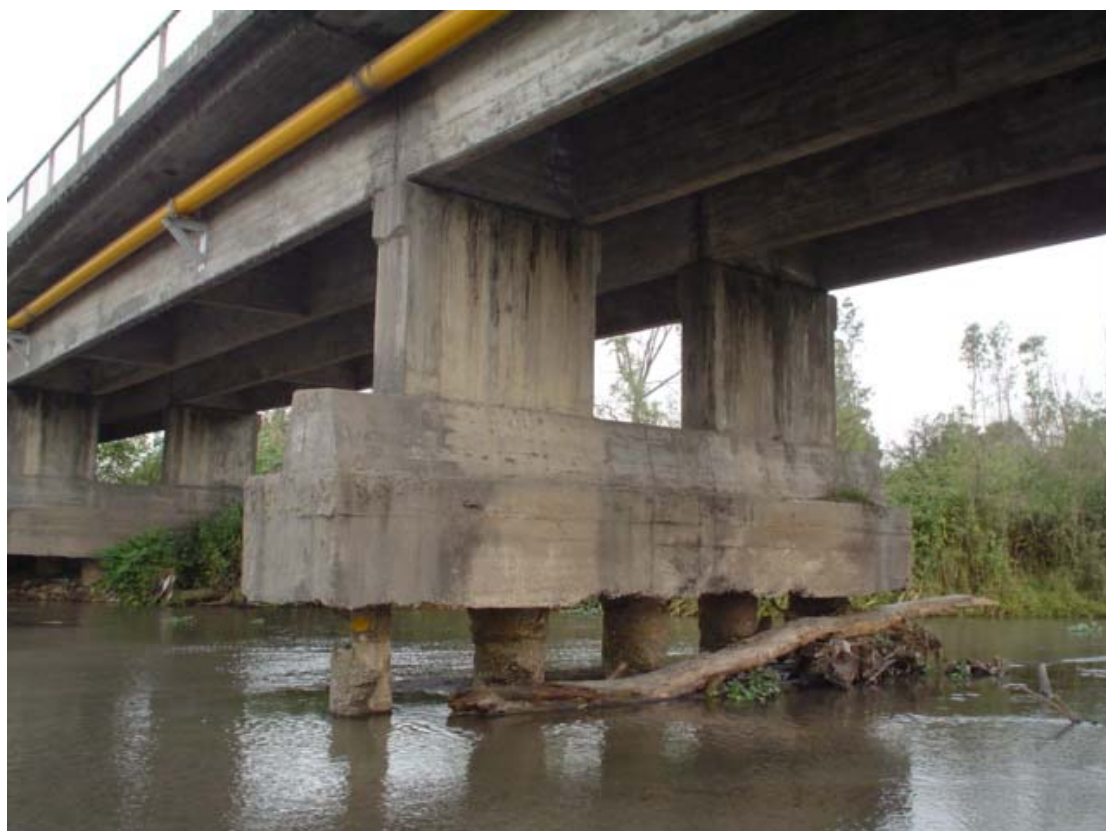
Fotografía 3.20: Erosión de capa de protección de hormigón en extremo superior de pilotes, Pila N° 2
