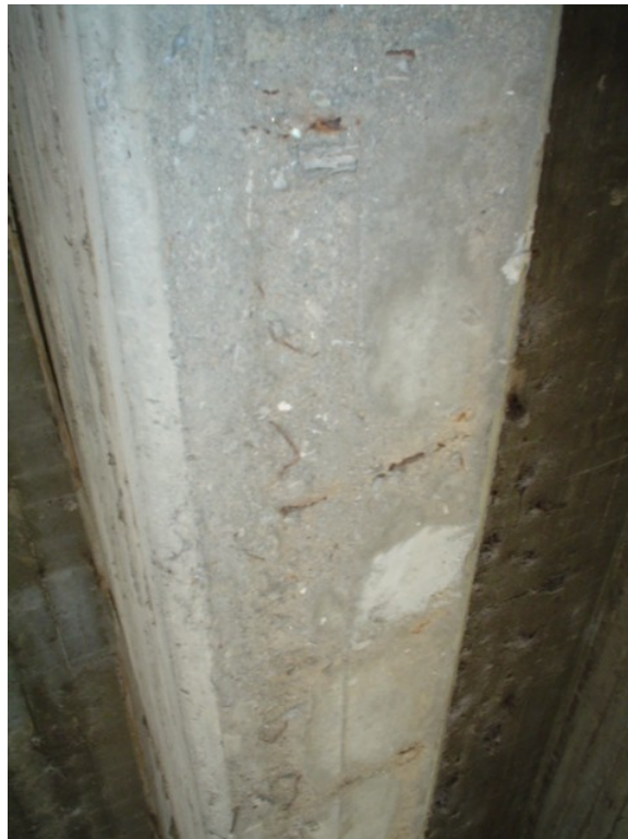
Fotografía 3.11: Escaso recubrimiento en fondo de viga.
