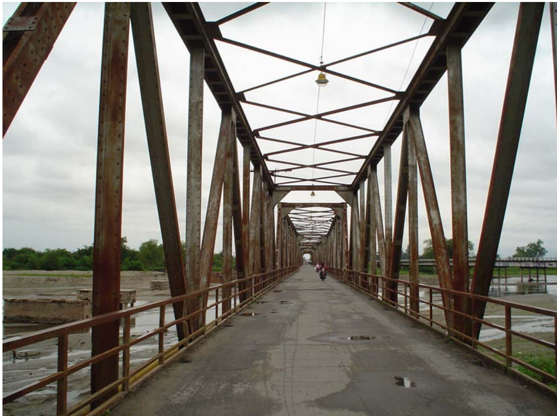
Fotografía 3.49: Defectos en carpeta de rodamiento.
