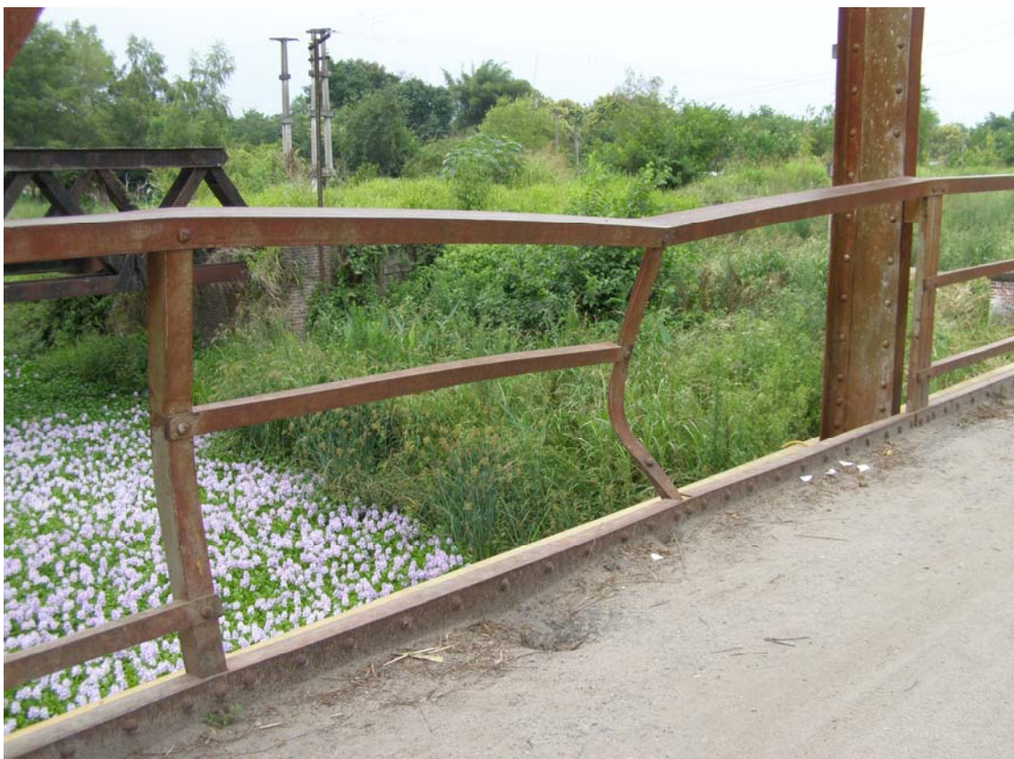
Fotografía 3.51: Daños en baranda, elementos faltantes y otros a reparar
