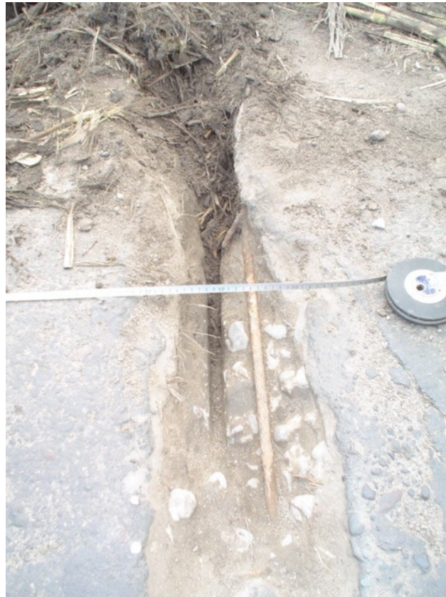
Fotografía 3.24: Junta saltada con exposición de armadura extrema.
