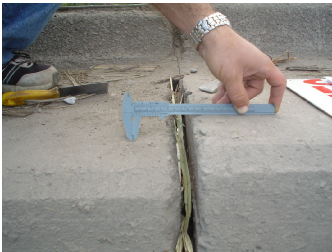
Fotografía 3.13: Descenso relativo del extremo del tercer tramo en correspondencia con Pila N° 3
