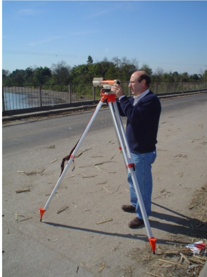
Fotografía 3.7: Nivelación del Tablero.
