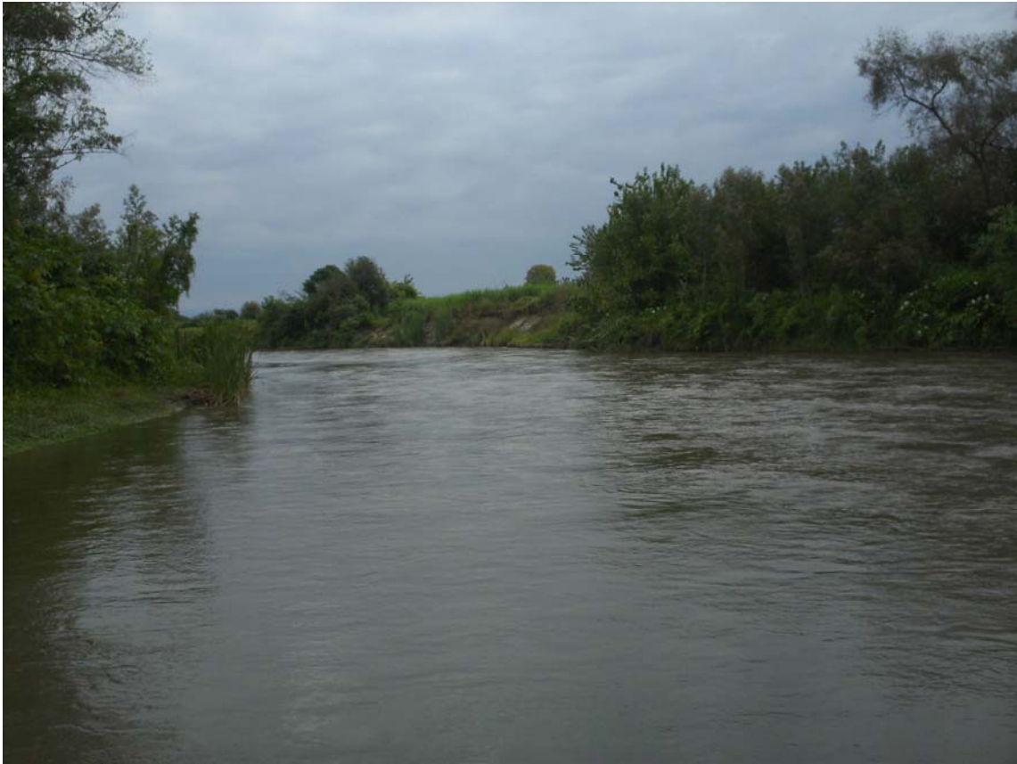
Fotografía 3.3: Márgenes erosionadas del río Pueblo Viejo aguas arriba del puente
