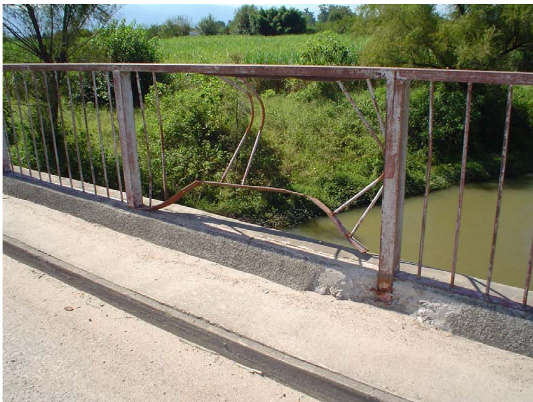
Fotografía 3.26: Baranda metálica dañada por impacto
