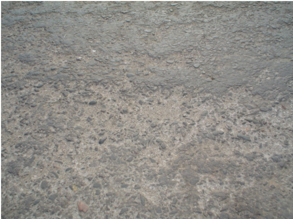
Fotografía 3.22: Desintegración progresiva de la superficie
