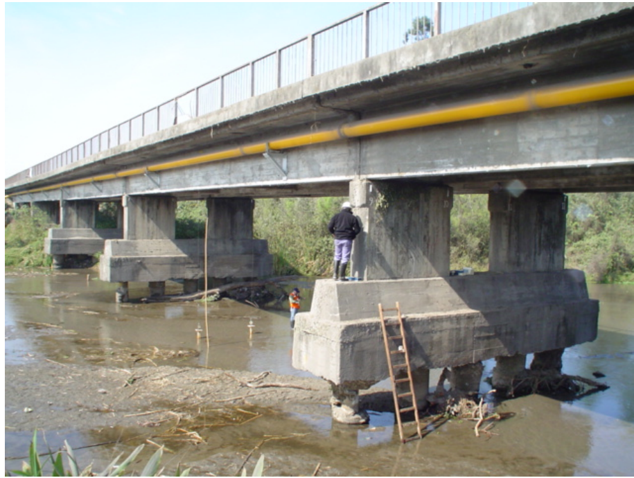
Fotografía 3.1: Vista del puente
