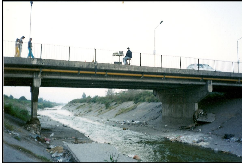
Figura 6.2 Vista general del puente ensayado.
