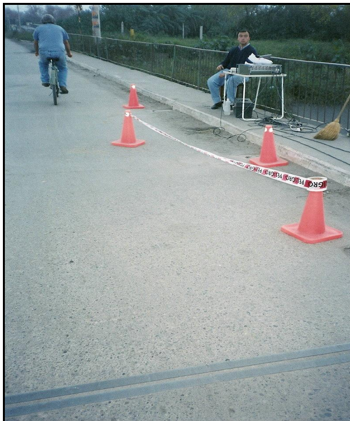
Figura 6.8 Zona de mediciones, sobre viga lateral
