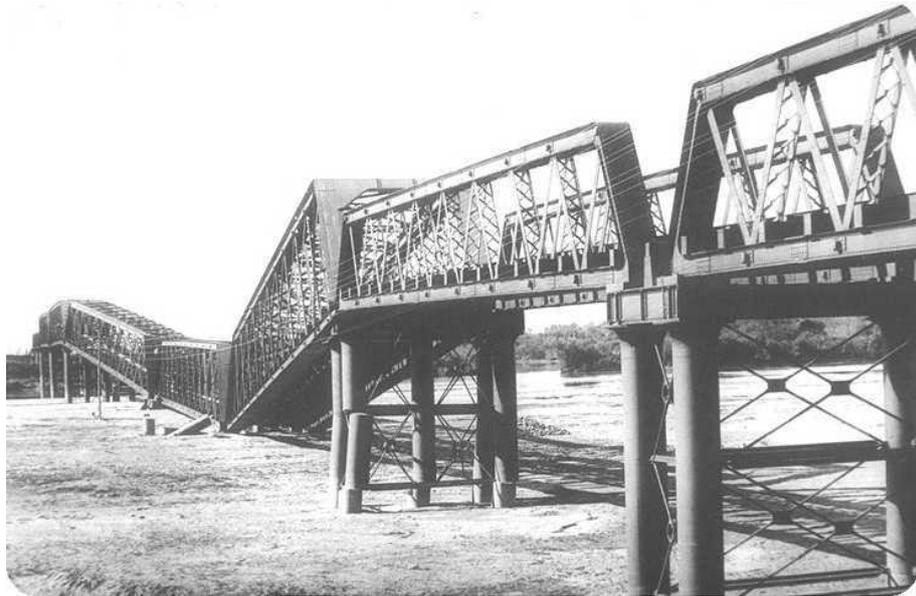
**FIGURA I- 2 :** Puente ferroviario Nagara Gawa, Terremoto de Mino Owari, Japón 1891 <sup>[I-12]</sup>
