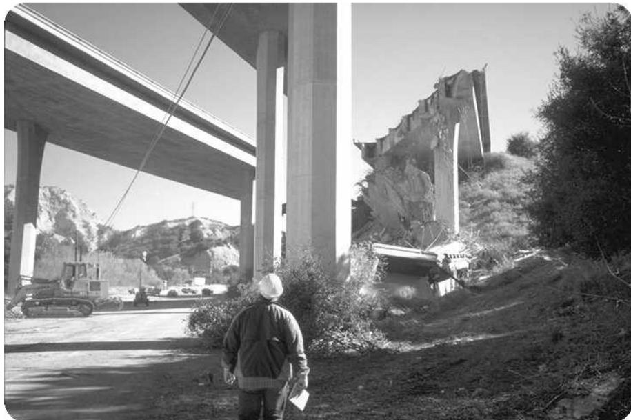
**FIGURA I- 11 :** Cuarto Tramo del puente 53-179 sobre la Interestatal – 5, Terremoto de Northridge, California, 17 de Enero de 1994 [I-15]
