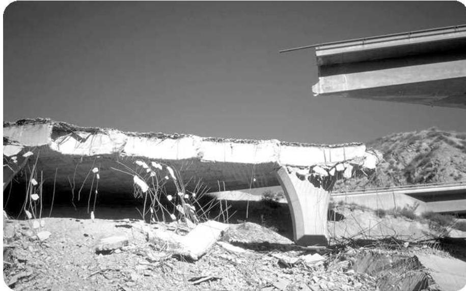
**FIGURA I- 10 :** Segundo Tramo del puente 53-179 sobre la Interestatal – 5, Terremoto de Northridge, California, 17 de Enero de 1994 [I-15]
