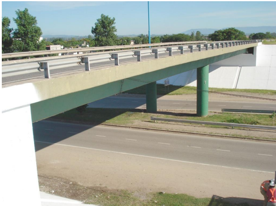
Figura 4.7. Vista longitudinal del puente derecho, sobre Av. Gobernador del Campo (P3).
