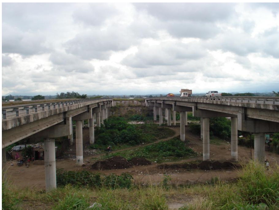
Figura 4.8. Vista longitudinal de los puentes sobre Ferrocarril Mitre (P4).
