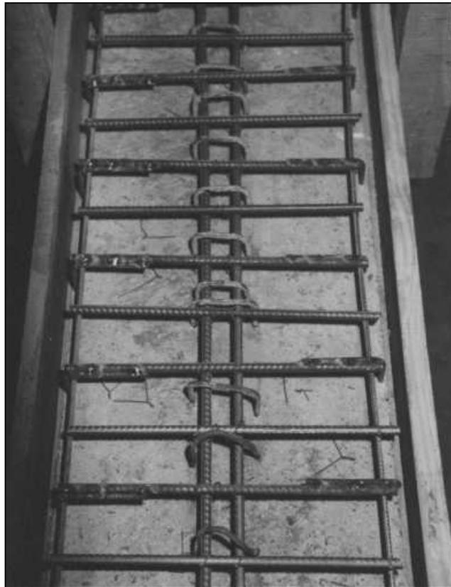
**Fotografía V-3: Curado Y Estribado De La Capa De Hormigón “In Situ”**
