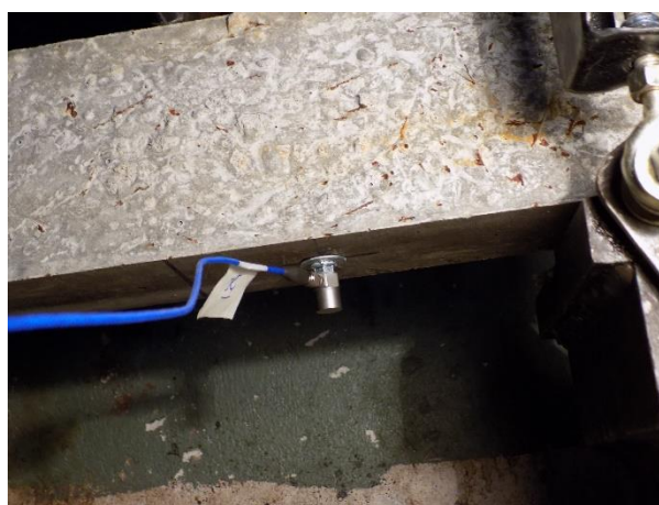
Figura 3.6: Montaje de los acelerómetros sobre las vigas.
