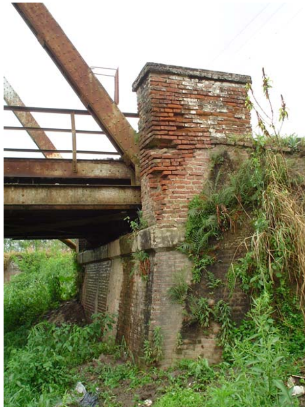
Fotografía 3.38: Estribos del tipo de caras facetadas.
