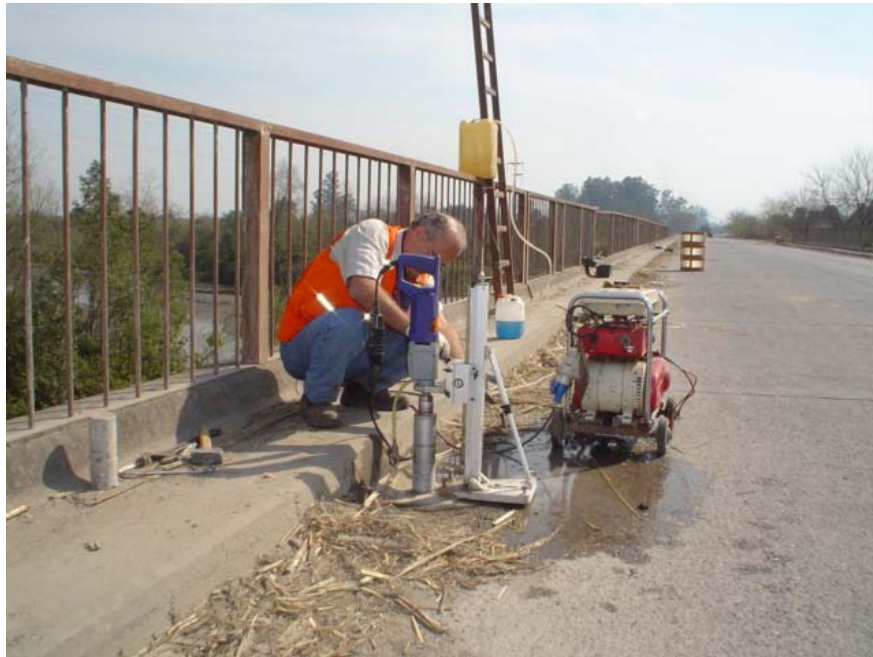
Fotografía 3.30: Extracción de testigos de losa del tablero
