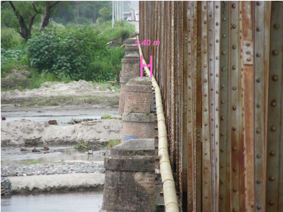
Fotografía 3.46: Rotación de la Pila 2, vista aguas arriba
