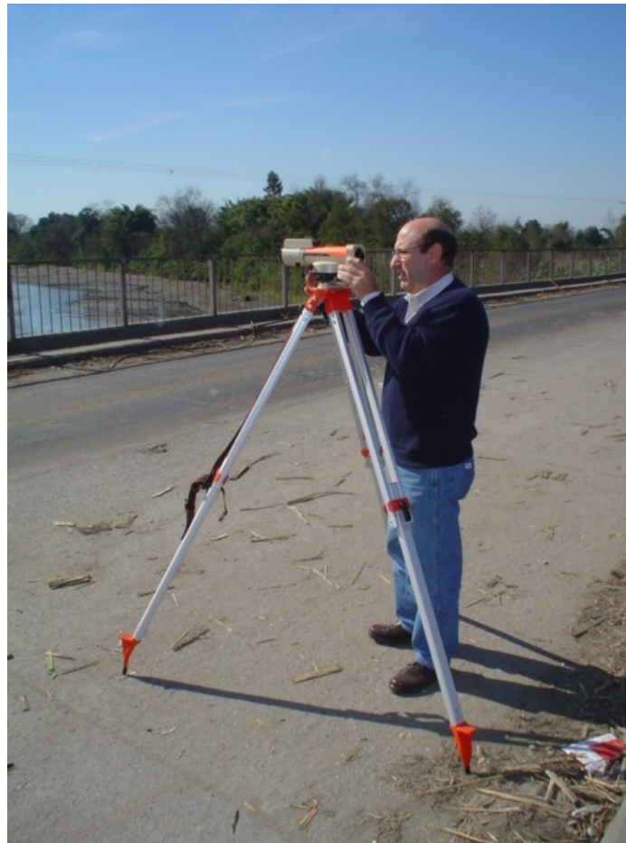
Fotografía 3.7: Nivelación del Tablero.
