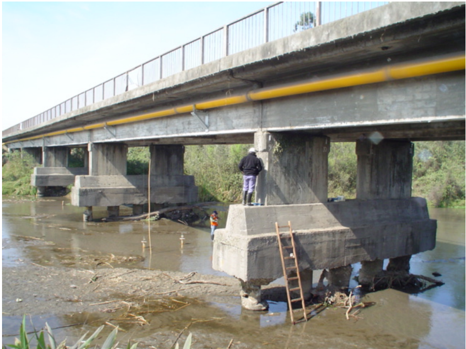
Fotografía 3.1: Vista del puente
