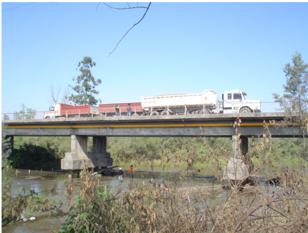
Fotografía 5.3: Segundo estado de carga con dos camiones
