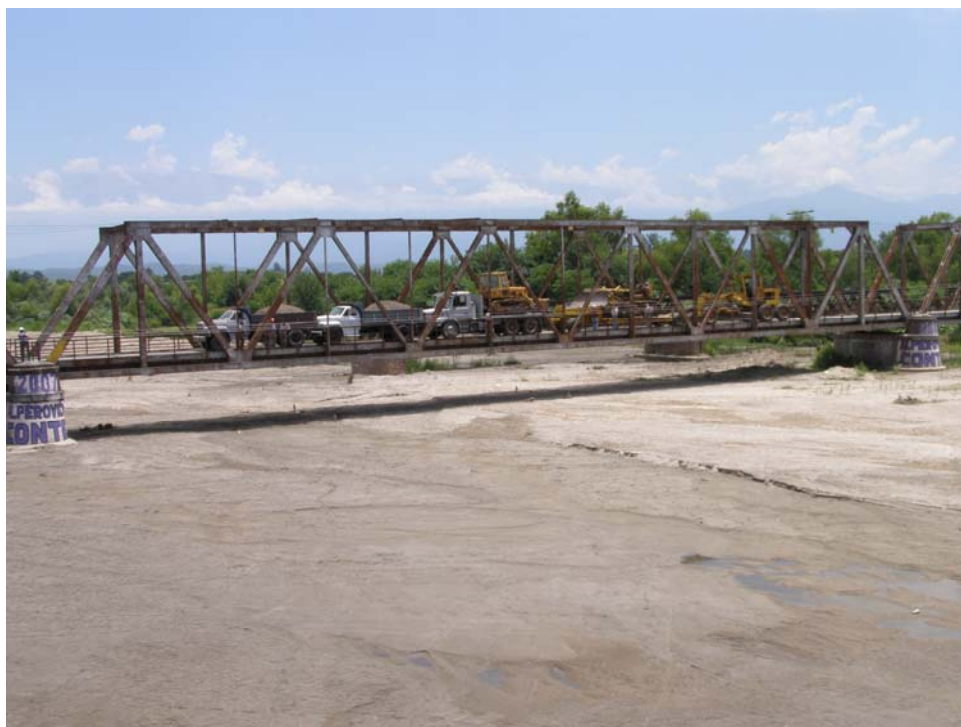
Fotografía 5.4: Estado de carga 4
