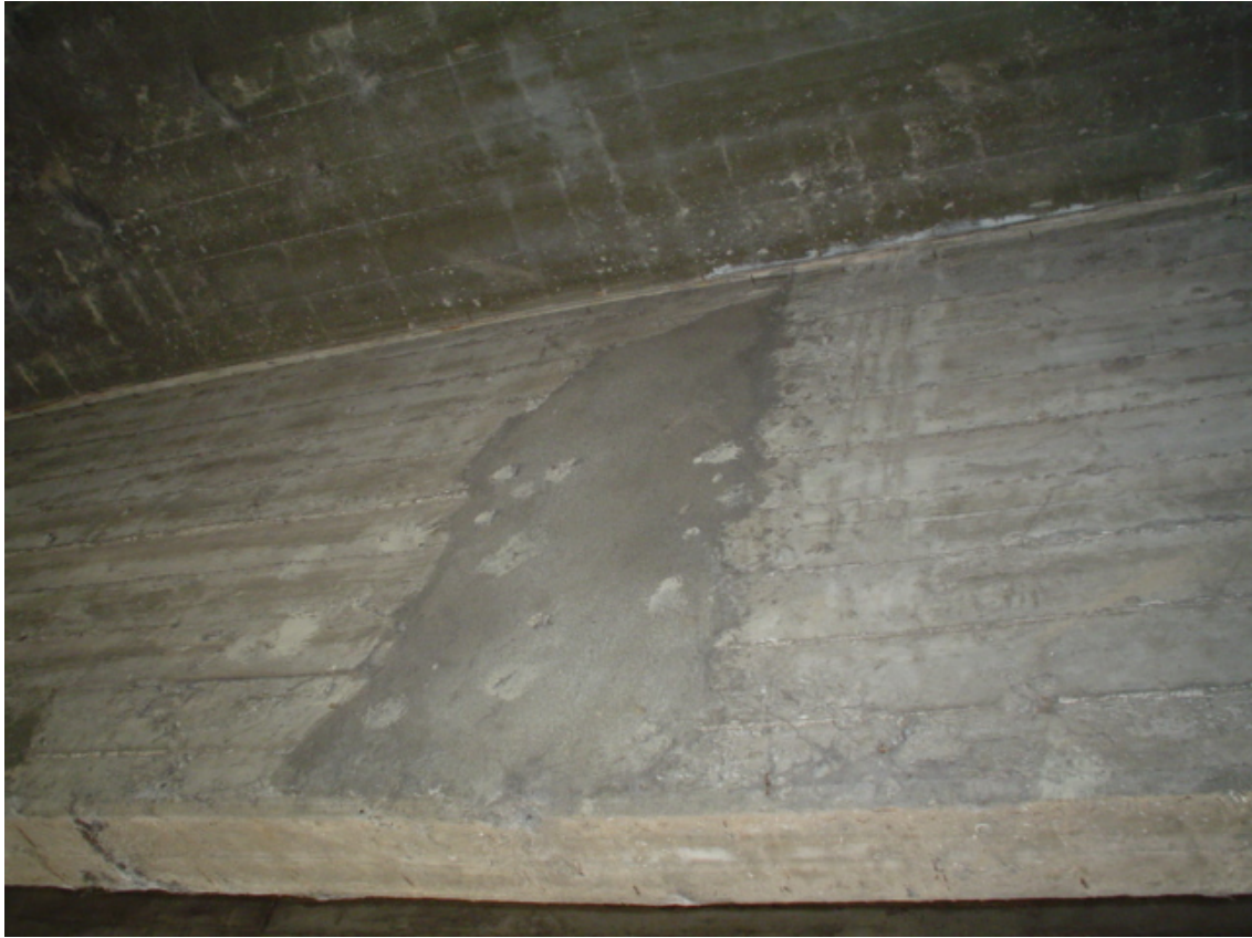
Fotografía 3.14: Retoque superficial en cara lateral de viga mediante revoque
