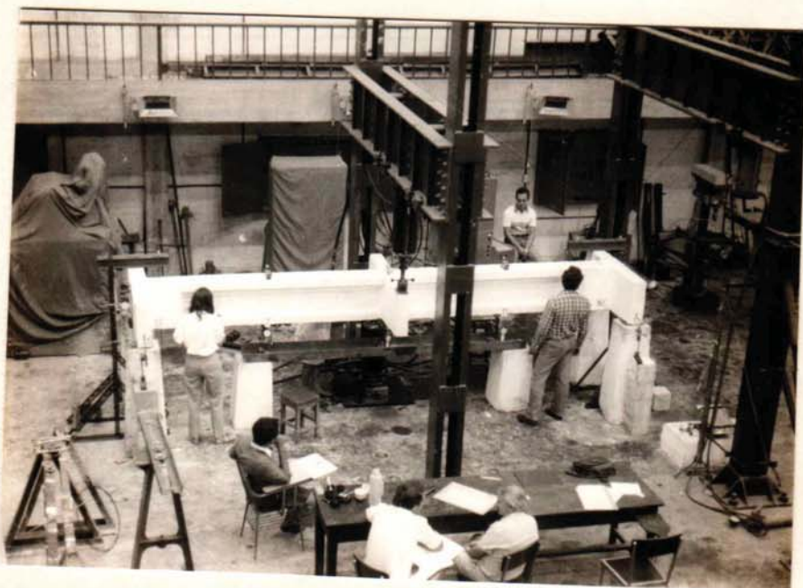
FOT. 4 ENSAYO A TORSION SIMPLE
