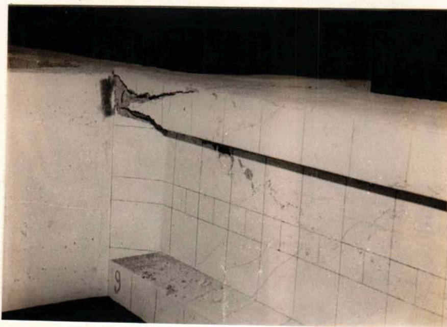
FOT. 7 ROTURA VIGA 1T
