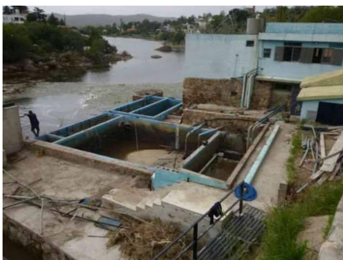
Figura 2: Imagen de la planta de Tratamiento de agua potable de la Cooperativa San Roque (barrio Villa de Lago en Villa Carlos Paz).
