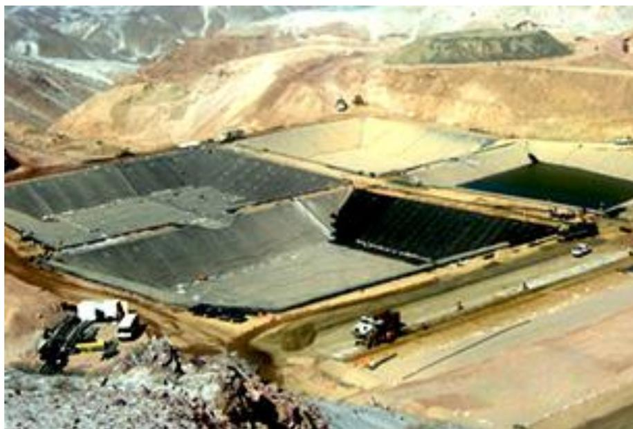
Figura 7.4- Construcción de lagunas de oxidación con geomembranas. Fuente: Grupo TDM. <http://www.tdm.com.pe/soluciones-impermeabilizacion-lagunas-de-oxidacion.php>
