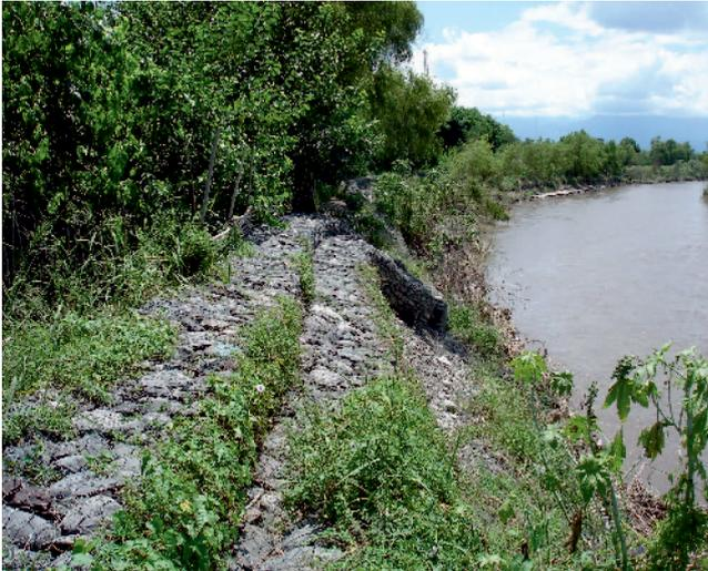
Fig. 2 Colapso de muro a lo largo de 25 m.
