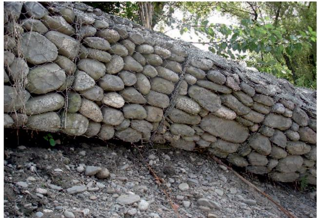
Fig. 4 Mallas con distintas deformaciones.
