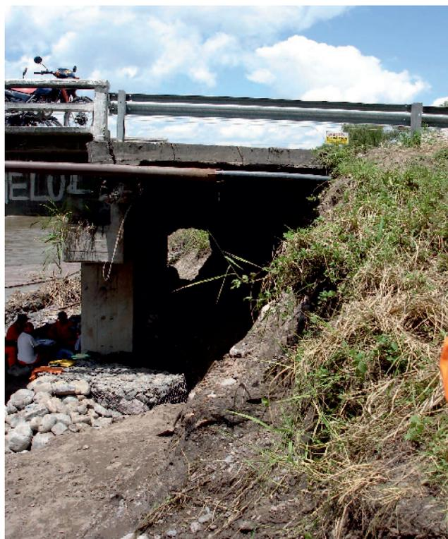
Fig. 1 Socavación de la cabecera del puente.
