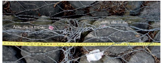
Fig. 15 Los alambres de borde no acompañan al alargamiento de la malla. ABL de la tapa y ABL de la caja.
