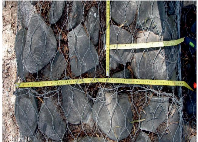
Fig. 10 La subdivisión evidencia la contracción transversal del gavión.
