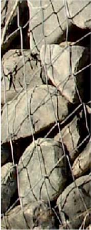
Fig. 25 Vista de la malla deformada.
