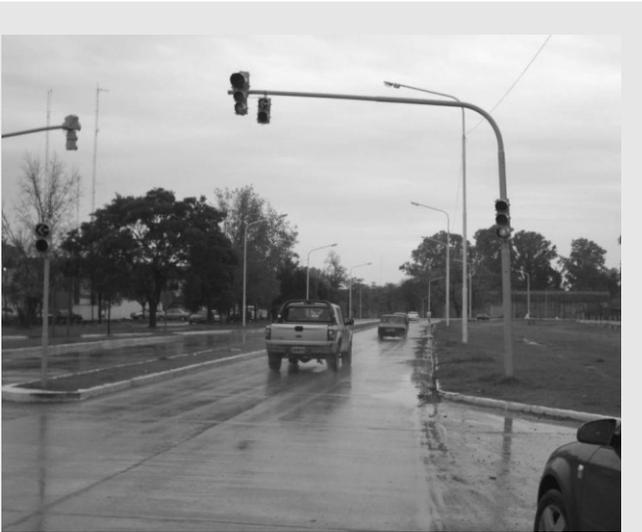
Fig. 8 Semáforo con unidad óptica con forma y dimensiones inadecuadas.
