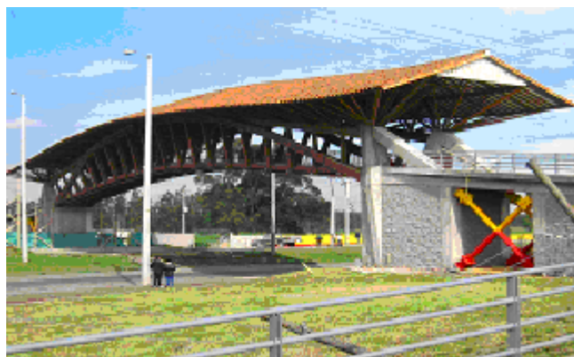
Fig. 3 Puente Peatonal en Bogotá – Simón Vélez.
