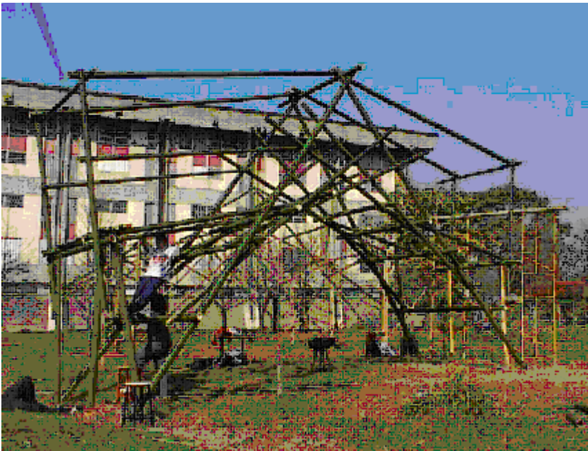
Fig. 8 Modelo C - sistema de vigas coplanares de eje quebrado.
