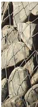
Fig. 25 Vista de la malla deformada.
