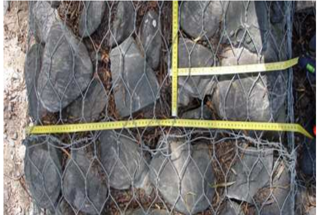
Fig. 10 La subdivisión evidencia la contracción transversal del gavión.
