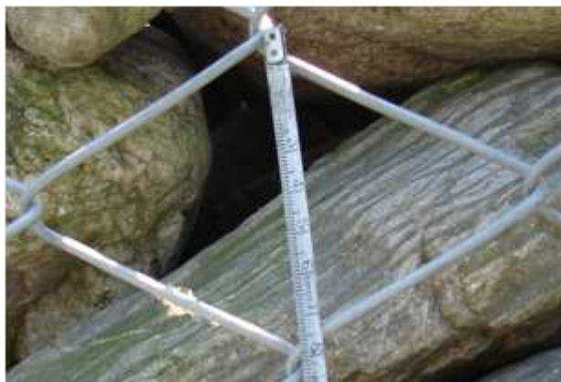
Fig. 20 Medición de diagonal transversal.
