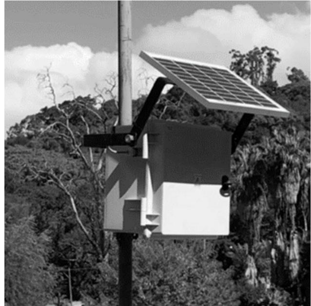
Figura 19. Conjunto panel solar y gabinete sujetado al mástil del CAPS los Bulacio.
