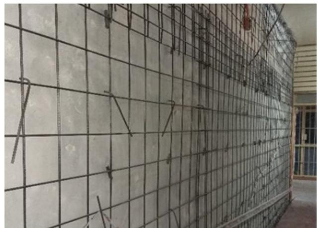
**Figura 1 (c):** Algunas estrategias de refuerzo sísmico en es escuelas de Mendoza (transformación de muros de mampostería encadenada en muros reforzados con armadura distribuida)
