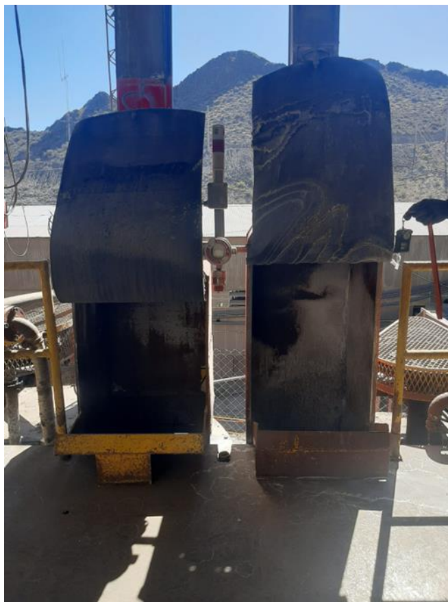
Ilustración 21. Chimenea de preparación de solución cianurada Nro. 1 y 2. Planta convencional.
