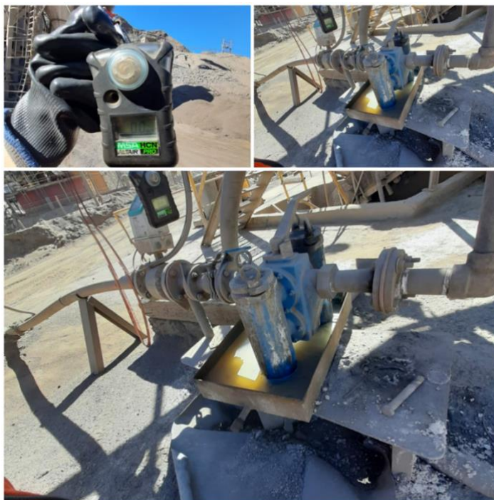
Ilustración 19. Válvula de cierre solución, playa II.
