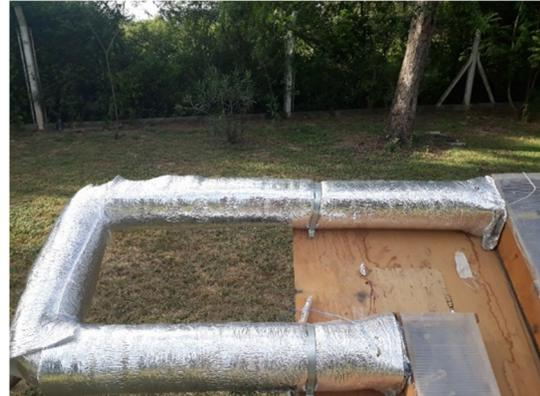
Figura 3: Colectores solares en paralelo, mediante unión T.
